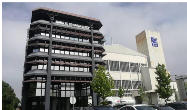
Figura 1- Edifício administrativo: RAR Açúcar
