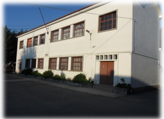
Anexo A IV – Fotografia Exterior da Escola
