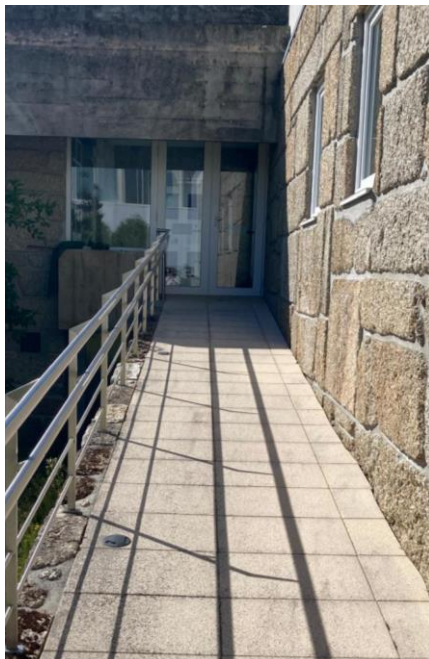
Figura 17 - Rampa de acesso ao Piso 1
