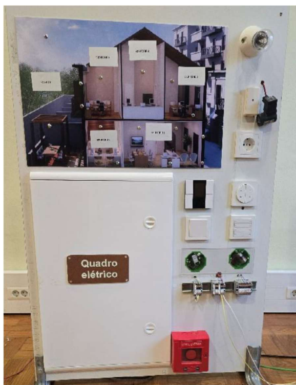
Figura 17 – Vista geral do painel de KNX
