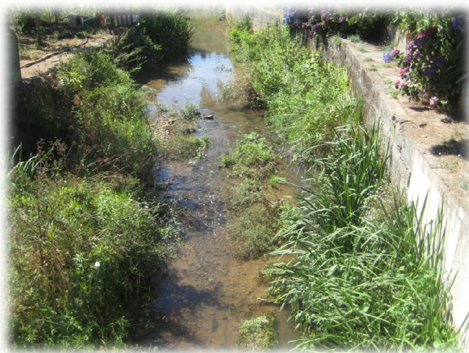
Figura 28 - Imagem do local a ser implementado o sistema de vigilância e alerta no rio Febros.
