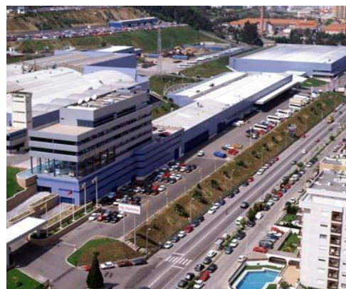
Figura 3. Infraestruturas da sede da CaetanoBus
