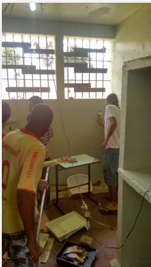
Figura 15 – Imagens das obras do curso de Pintor
