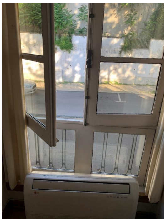
Figura 25 – Exemplo de vão envidraçado do edifício.
