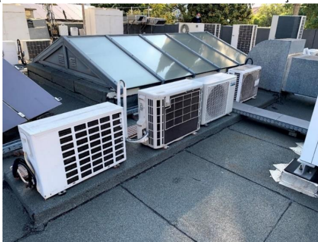
Figura 30 – Aspeto da cobertura do edifício.
