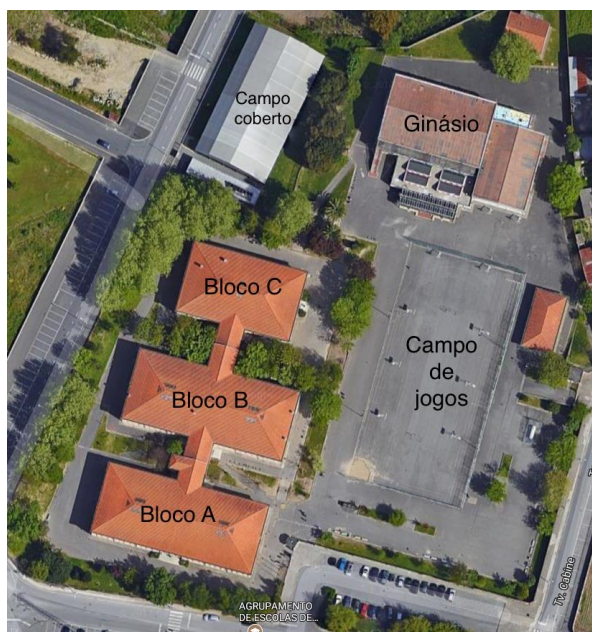
Figura 2 – Vista aérea da EB2,3.
