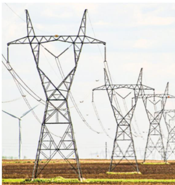
Figura 4 - Torre de Suspensão Autoportante [26]
