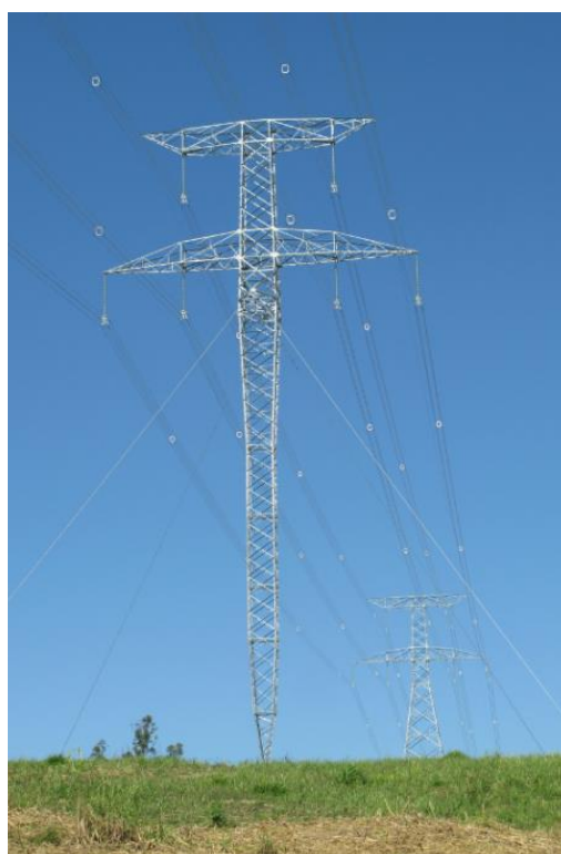
Figura 8 - Torre Estaiada Monomastro [28]
