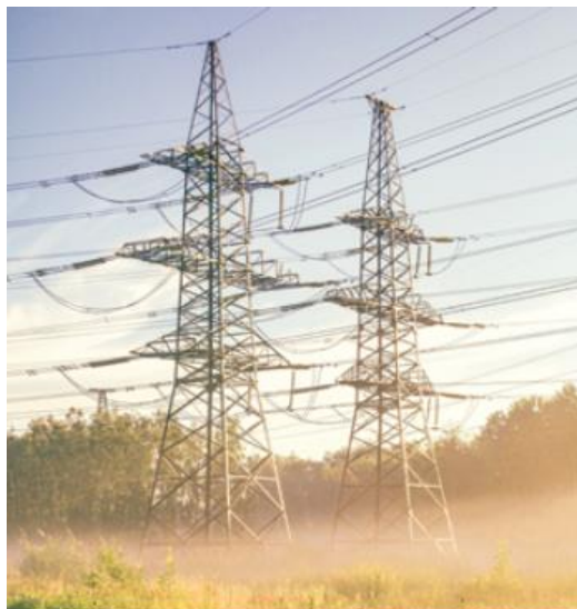
Figura 7 - Torres de Transposição de Fases [26]
