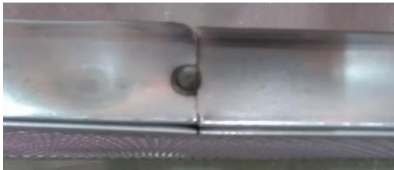
Figura 37 - Ponto de solda dado para fechar tampos
