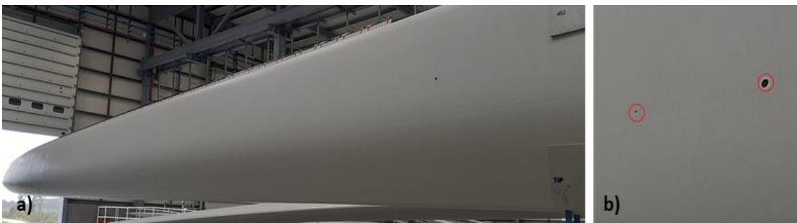
Figura 41 - Furos a) para enchimento da mistura num dos 3 calibradores (método inicial por gravidade) e detalhe dos furos em b).
