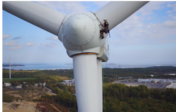
(c) Inspeção da estrutura exterior [29]
