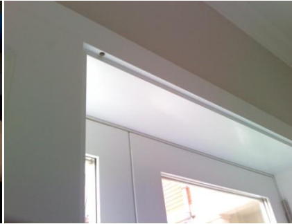
Figura 3.50 – Janela do Quarto
