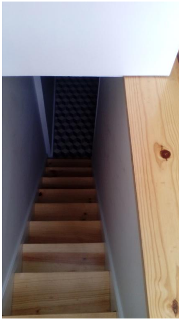
17) Escadas interiores de acesso entre cave e R/C (fração B)
