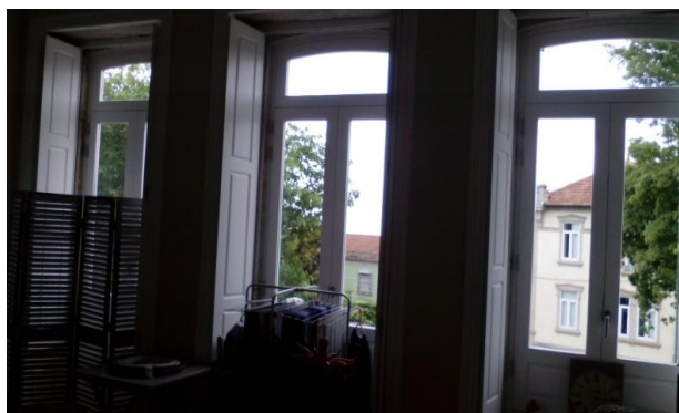
5) Envidraçados do piso 1 (fração A)
