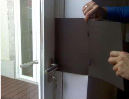
Figura 3.49 – Porta de acesso à varanda (fração C)
