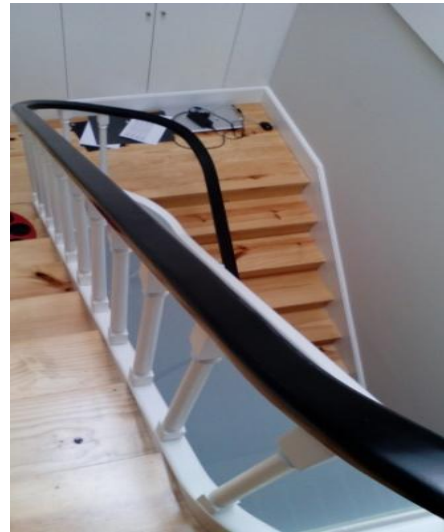
26) Escadas interiores de acesso do piso 1 ao piso 2 (fração D)
