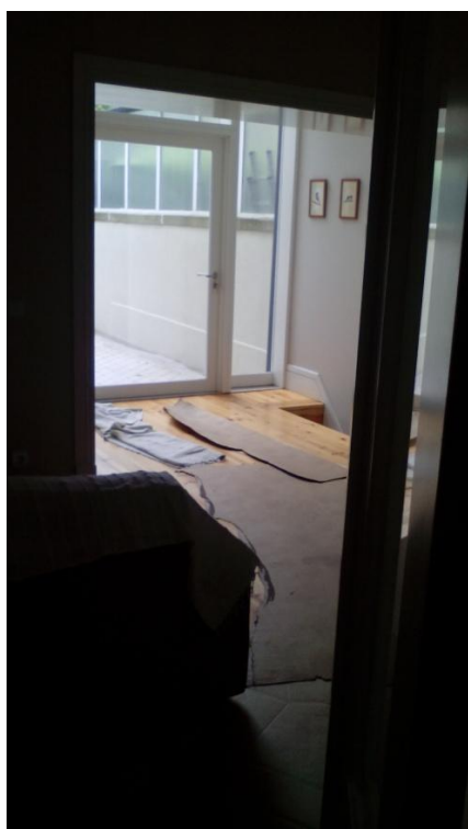
15) Vista interior do R/C (fração B)
