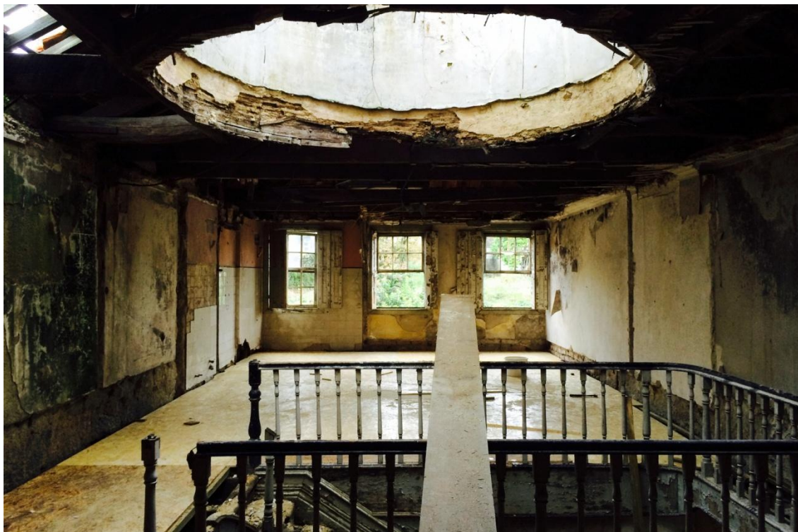
Figura 3.5 – Edifício (fração D) antes de sofrer obras de reabilitação
