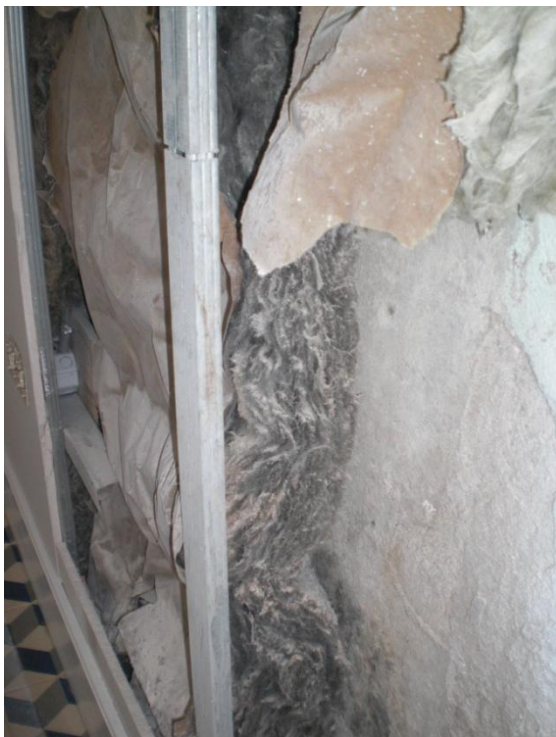
11) Colocação de isolamento pelo interior da parede existente (fração A)
