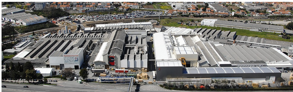
Figura 1.1: Vista aérea da sede da Efacec, na Arroiteia, Matosinhos
