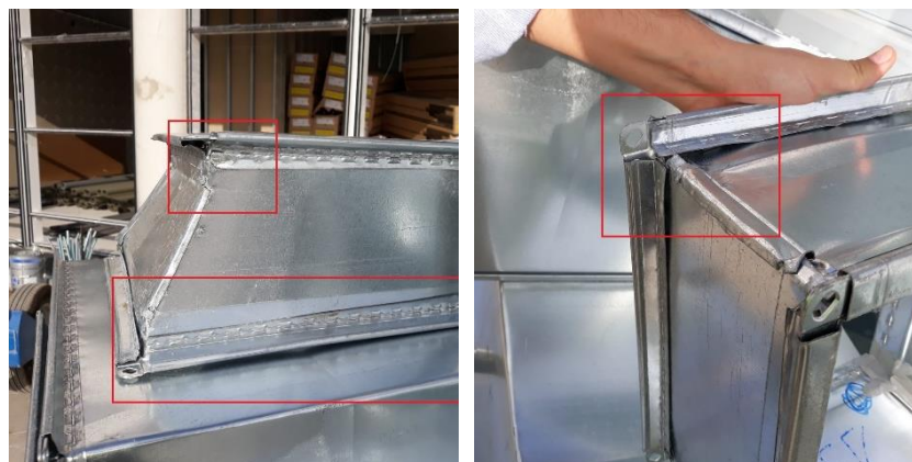
Figura 23 - Verificação do estado físico dos materiais.
