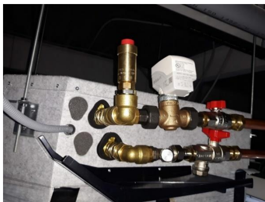
Figura 28 - Exemplo de montagem de kit hidráulico.
