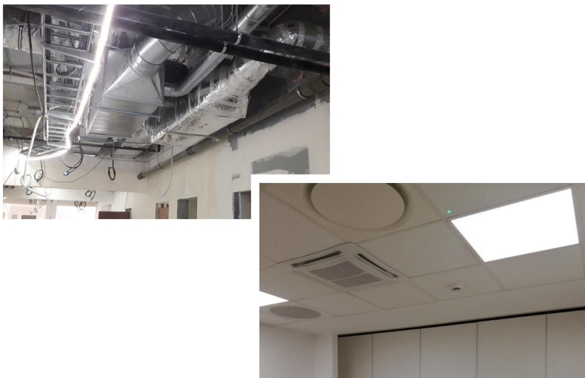
Figura 25 - Exemplo de instalação e montagem de condutas e difusores.
