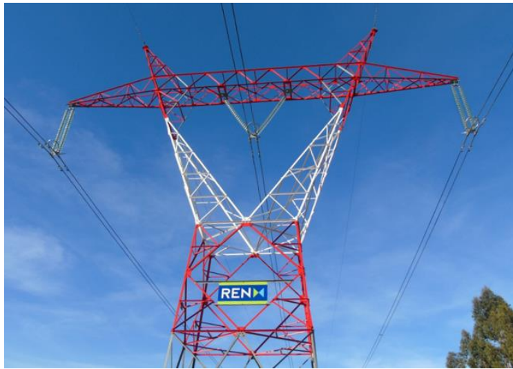
Figura 21 – Apoio com pintura de balizagem diurna (fonte: REN).
