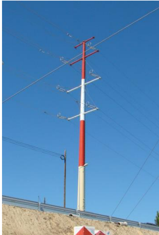
Figura 4 – Instalação de apoio tubular de linha dupla com cadeias em amarração (fonte: REN).
