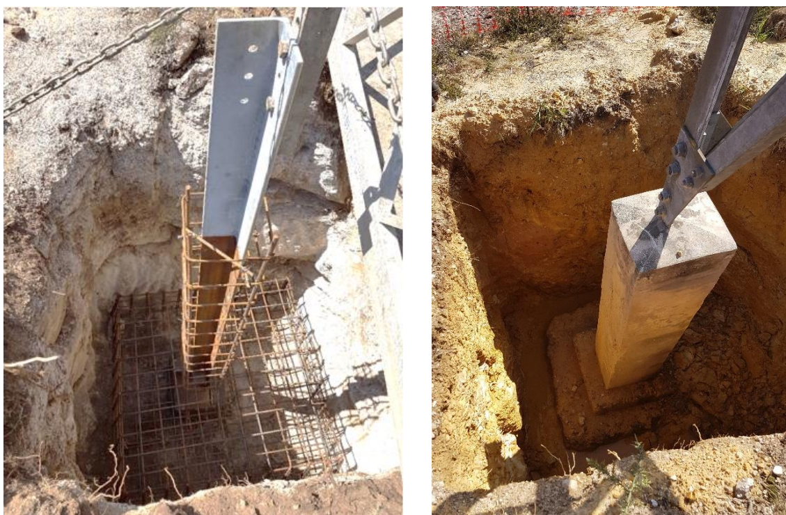
Figura 5 – Armadura de uma fundação (esquerda) e fundação destapada (direita), (fonte própria).
