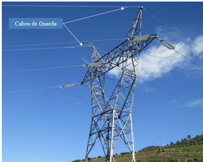
Figura 11 – Cabos de Guarda da RNT (fonte própria).
