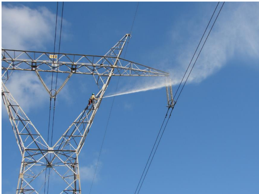
Figura 14 – Limpeza de isoladores em tensão (fonte: REN).
