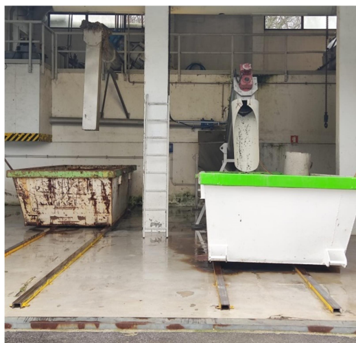
Figura 3.2: Contentores de recolha de sólidos gradados e tamisados.
