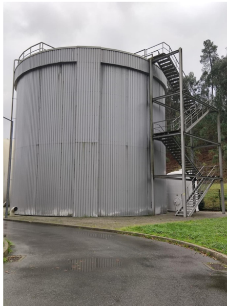
Figura 4.3: Digestor anaeróbio.
