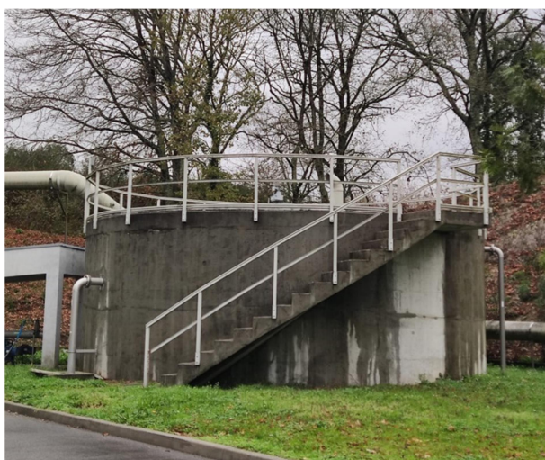
Figura 4.1: Espessador gravítico de lamas primárias.
