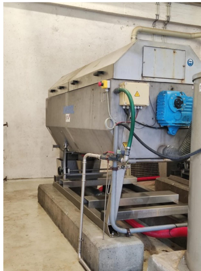
Figura 4.2: Tambores de espessamento mecânico de lamas em excesso.
