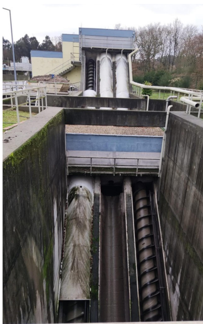
Figura 3.1: Parafusos de Arquimedes-elevação inicial.
