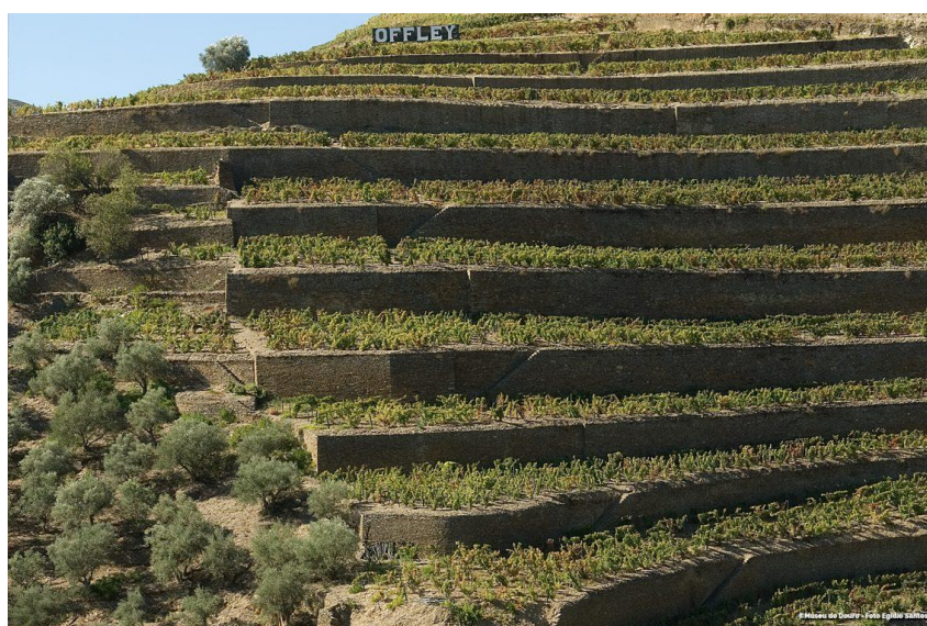
Figura 1 - Muros de gravidade aplicados nos socalcos do Douro (Santos, 2020).
