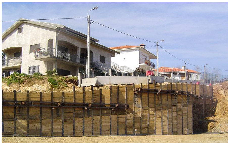
Figura 6 - Parede tipo Berlim provisória ancorada (Ancorpor, 2020e).
