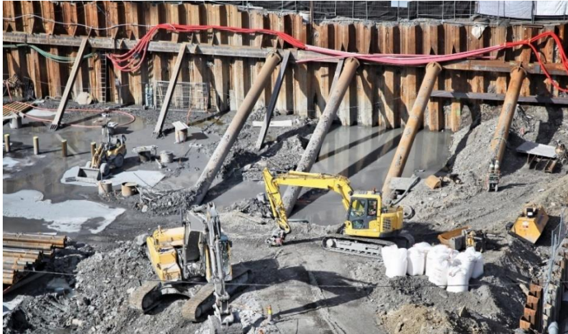
Figura 32 - Escoras metálicas inclinadas em parede de estacas-pranchas (IRONLOT, 2025).
