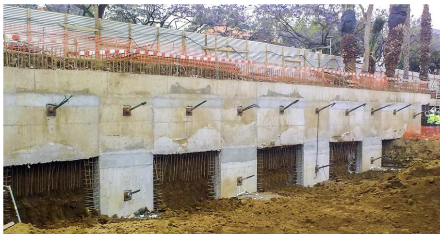
Figura 12 - Execução de painéis secundários no segundo nível de parede tipo Berlim definitiva (Ancorpor, 2020a).
