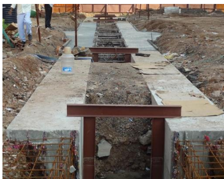
Figura 25 - Execução de muros-guia (BUMI, 2013).
