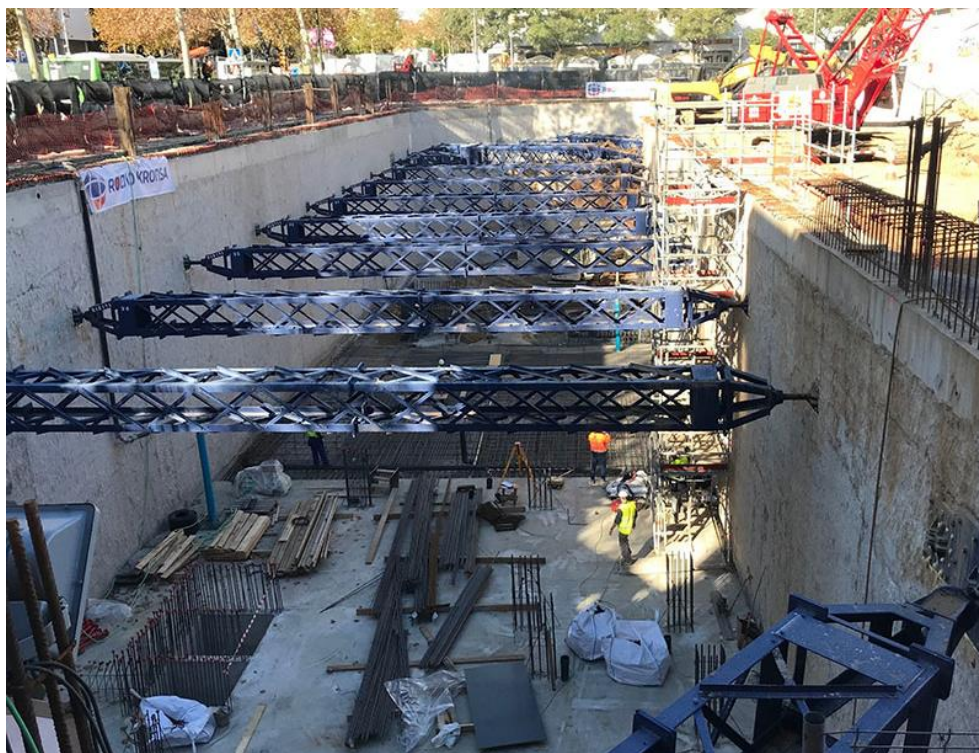
Figura 29 - Parede moldada escorada (Rodio, 2019b).
