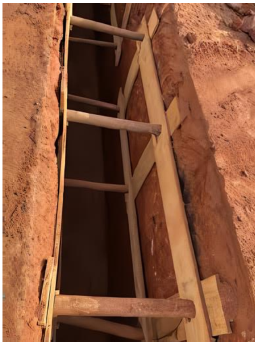
Figura 3 - Entivação tradicional para rede de esgoto (TaurosEmpreendimentos, 2019).
