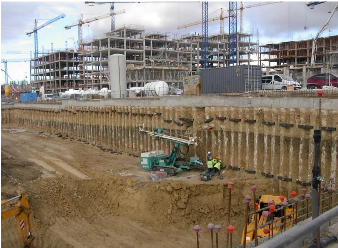
Figura 14 - Cortina de estacas moldadas ancoradas (Ancorpor, 2020g).
