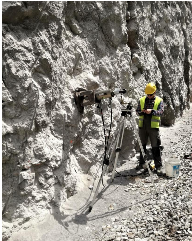
Figura 51 - Ensaio de ancoragem (Geotech, 2025)
