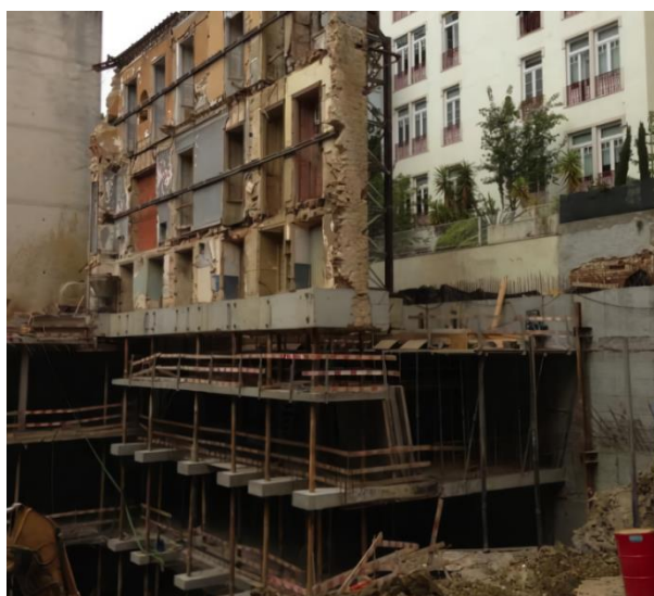
Figura 70 - Cortina suportada por lâminas de betão (Cunha, 2014).
