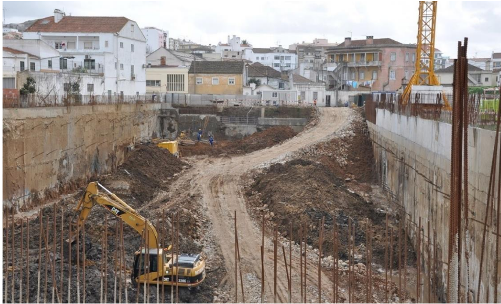
Figura 30 - Parede moldada ancorada (Ancorpor, 2020f).
