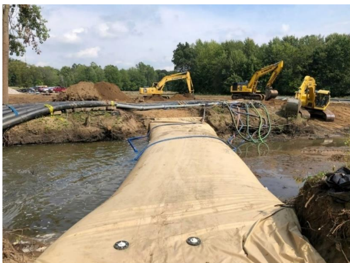
Figura 5 - Entivação não tradicional para contenção de linha de água existente (Murlac, 2022).
