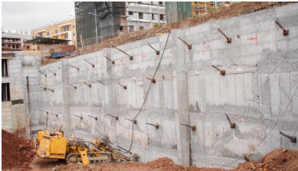
Figura 11 - Parede tipo Berlim definitiva ancorada (Ancorpor, 2020c).
