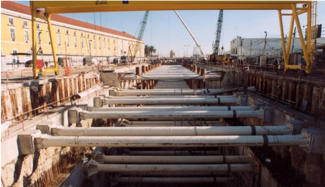
Figura 15 - Cortina de estacas moldadas escoradas (Teixeira Duarte Construção, 2025).
