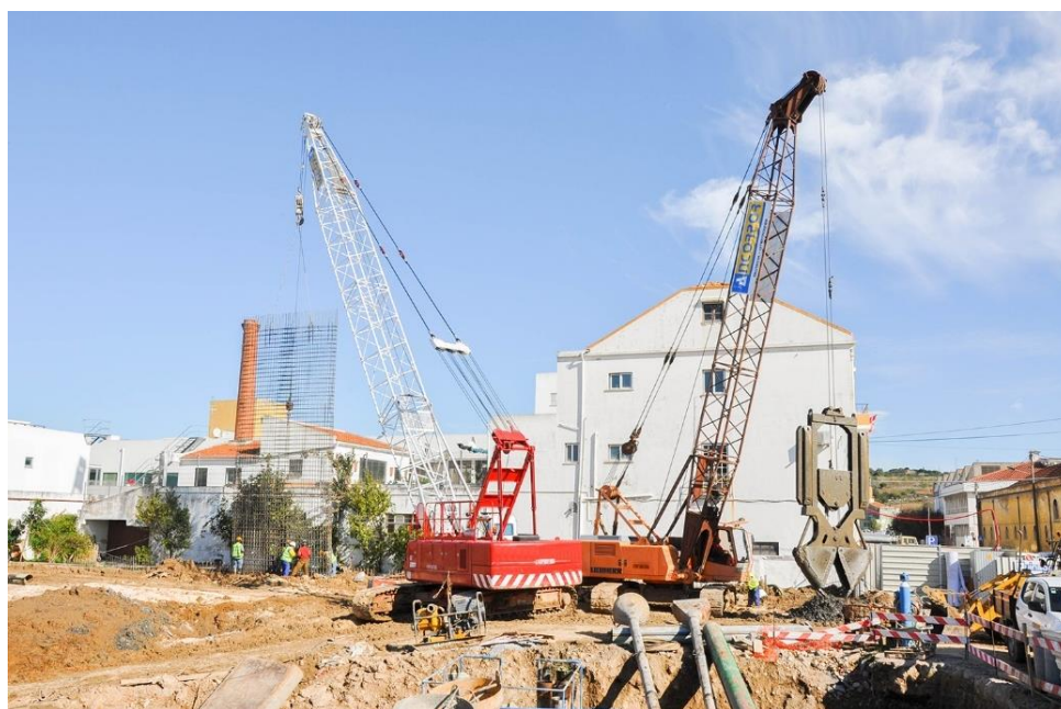
Figura 28 - Inserção de armaduras em painel de parede moldada (Ancorpor, 2020h).
