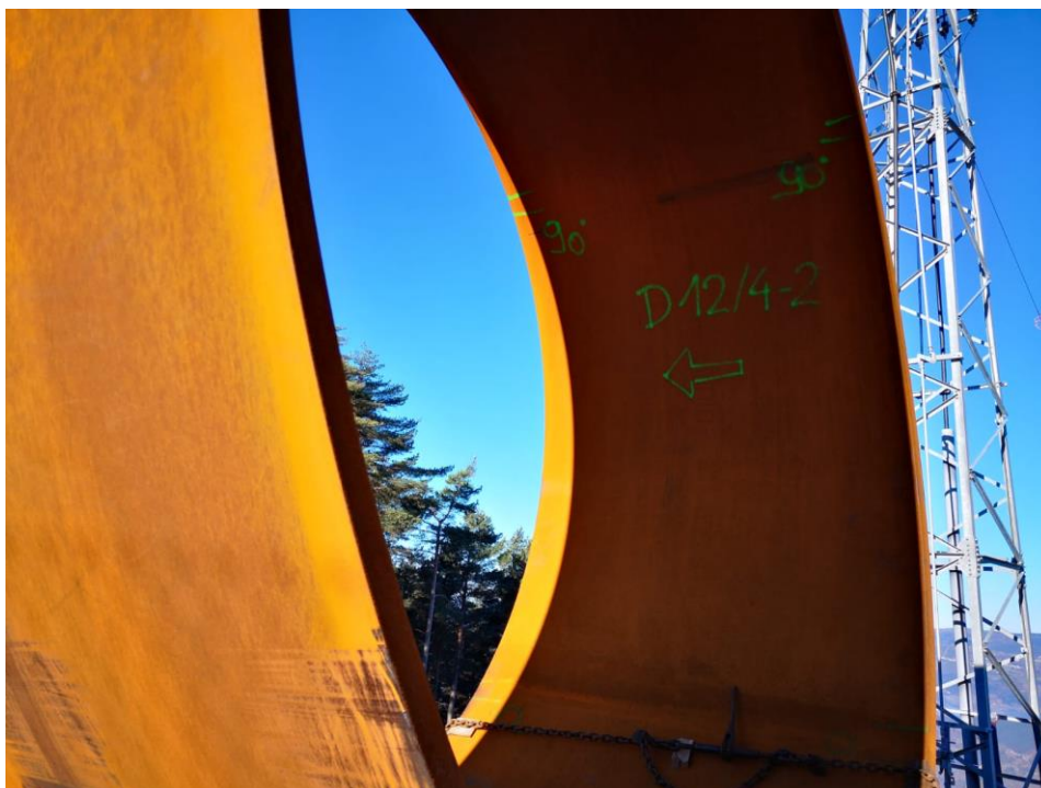
Figura 44 - Marcação dos tubos fabricados e prontos para instalar, no caso a verde
