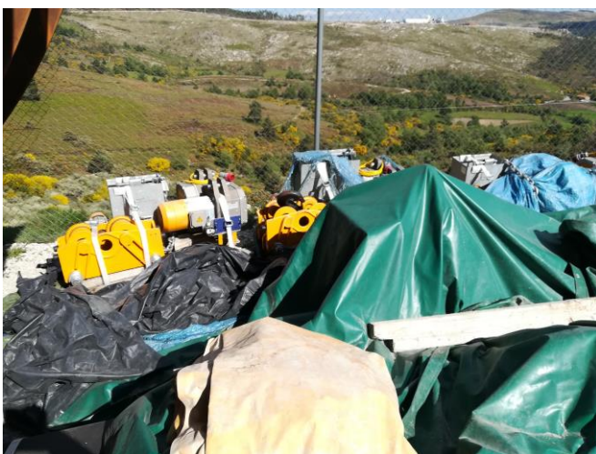
Figura 37 - Equipamentos na zona de estaleiro
