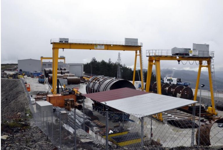
Figura 34 - Fotografia do Estaleiro em funcionamento
