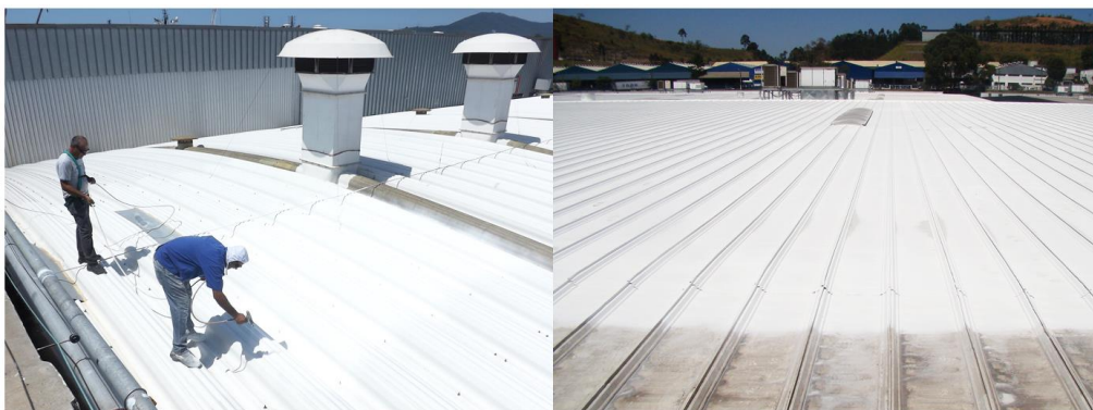
Figura 5.13 – Aplicação e aspeto do produto Nanothermic 1[51]
