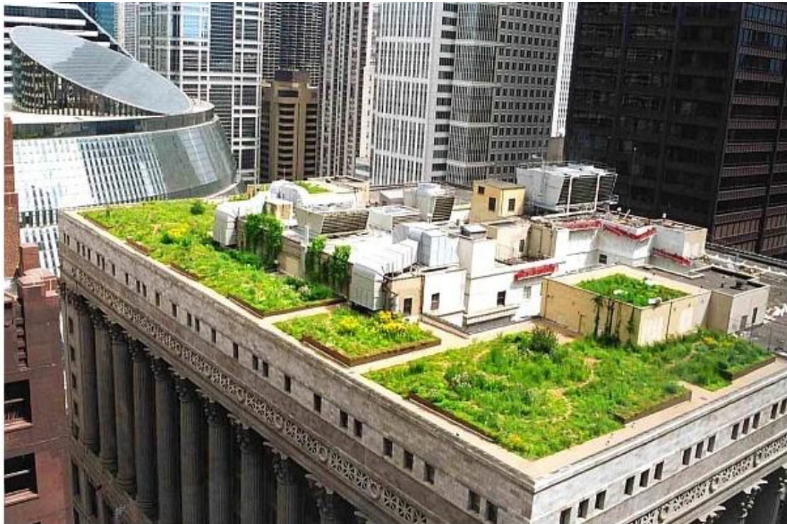
Figura 5.12 – Cobertura verde do City Hall em Chicago, EUA. [48]
