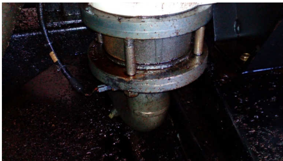
Figura 160 - Fuga de óleo pela válvula anti-retorno da descarga do airend (Fonte: Ingersoll-Rand )
