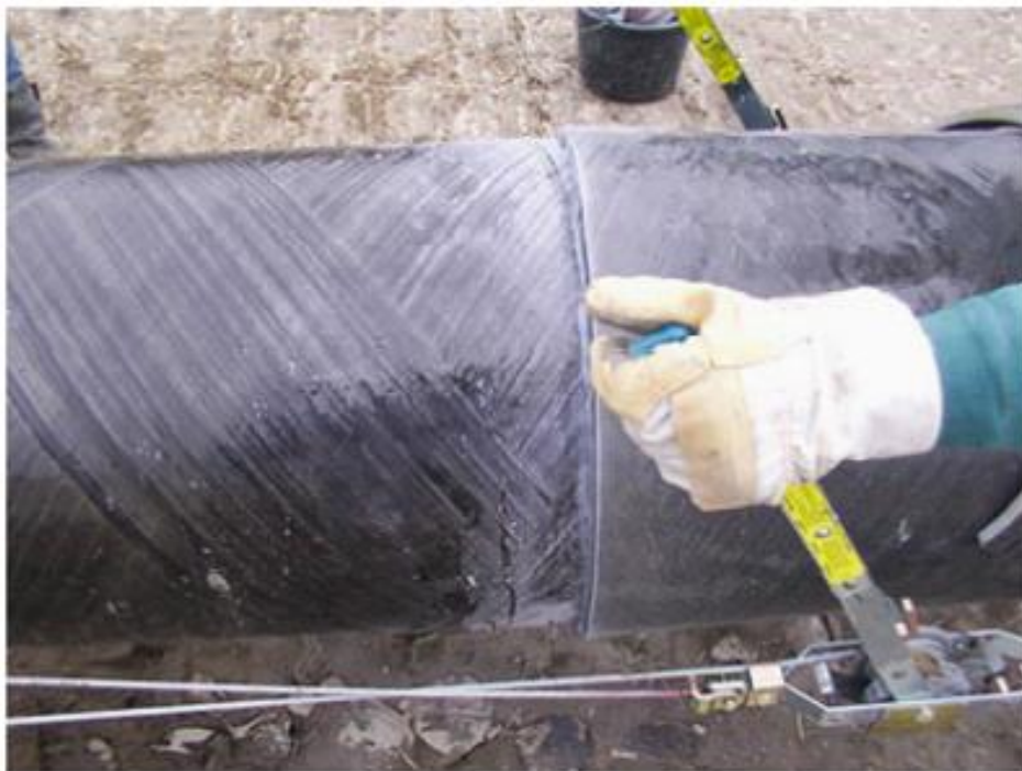
Figura 27 - Montagem de tubagens para estruturas offshore [118]
