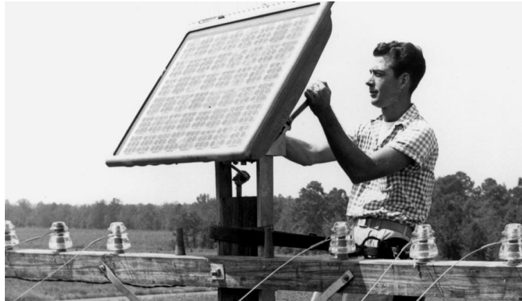
Figura 21 - Primeira célula de Silício aplicada na Rede Telefónica.
