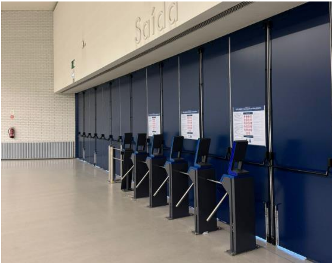
Figura 23 - Exemplos de obstáculos na saída da arena
