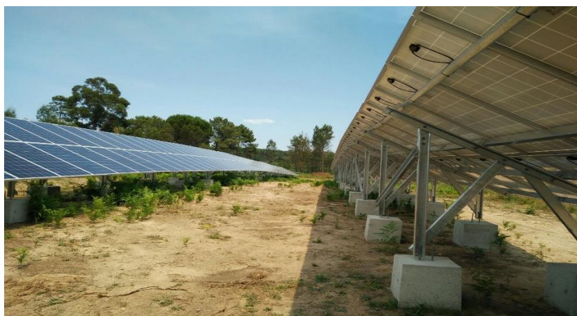
Figura 7.21: Montagem de estrutura no solo, com apoio em maciços de betão
