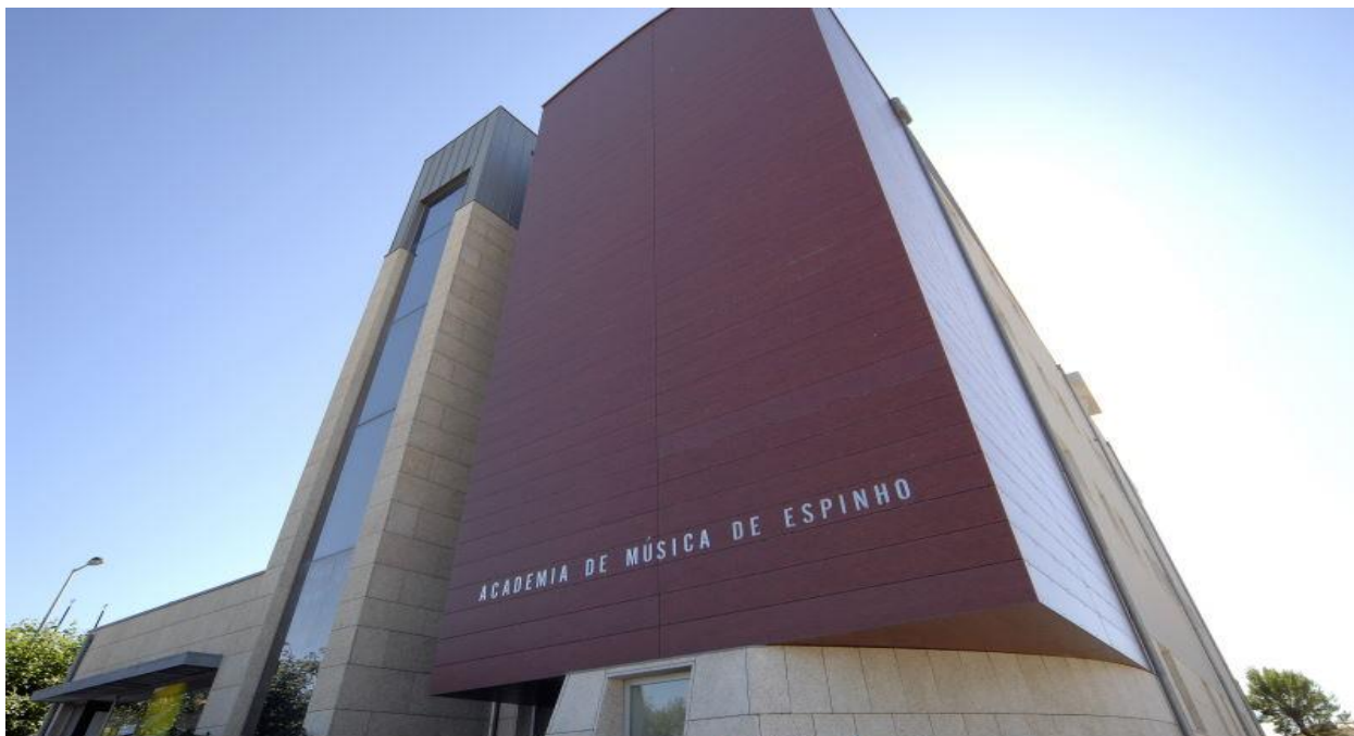
Figura 1 – Edifício da Academia de Música de Espinho
