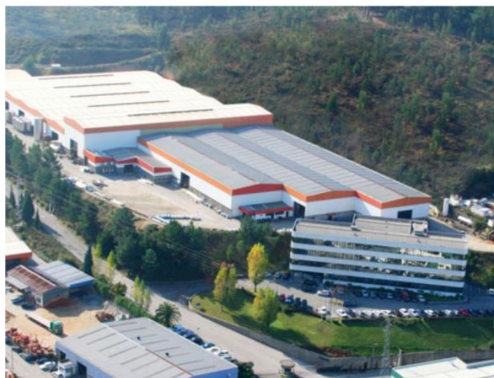
Figura 1 Instalações atuais da Metalúrgica Progresso
