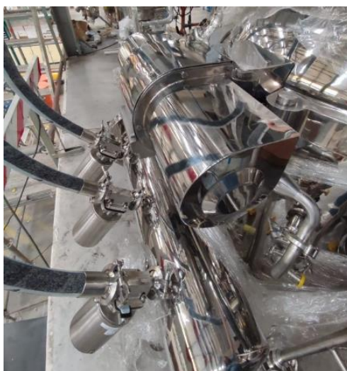
Figura 78 Instalação do cap balancer no Bag filter SD-653
