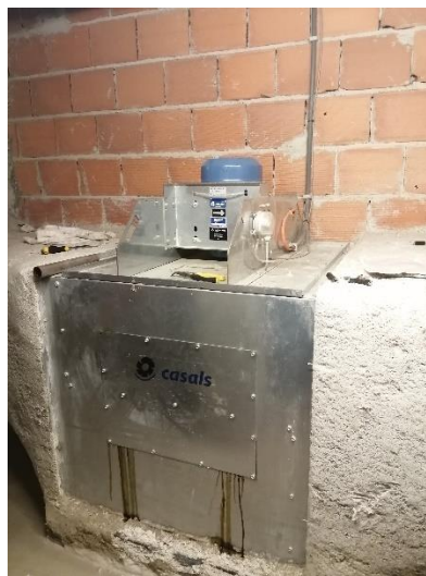
Figura 30 – Ventilador de extração.
