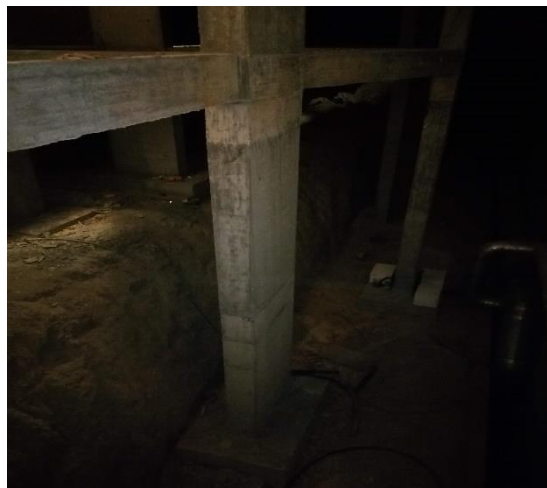
Figura 20 – Acessos muro de contenção.
