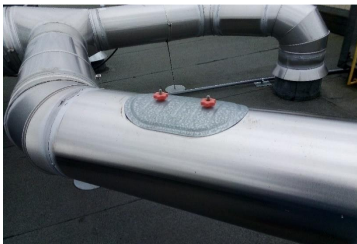
Figura 38 – Exemplo de conduta com janela de visita.
