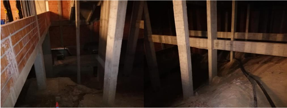
Figura 41 – Acessos atuais ao muro de contenção.
