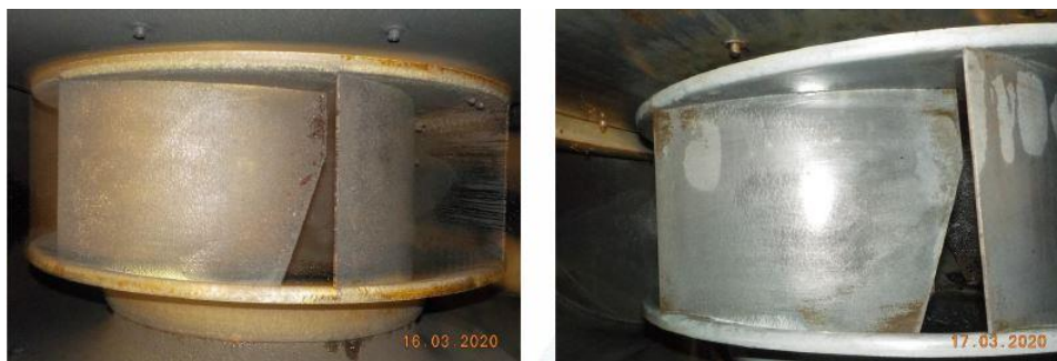
Figura 40 – Exemplo do antes e depois de limpeza de ventilador.
