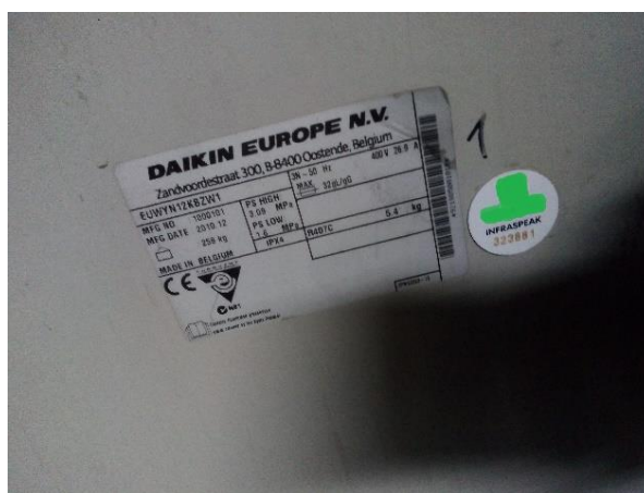
Figura 48 – Exemplo de identificação com etiqueta NFC.
