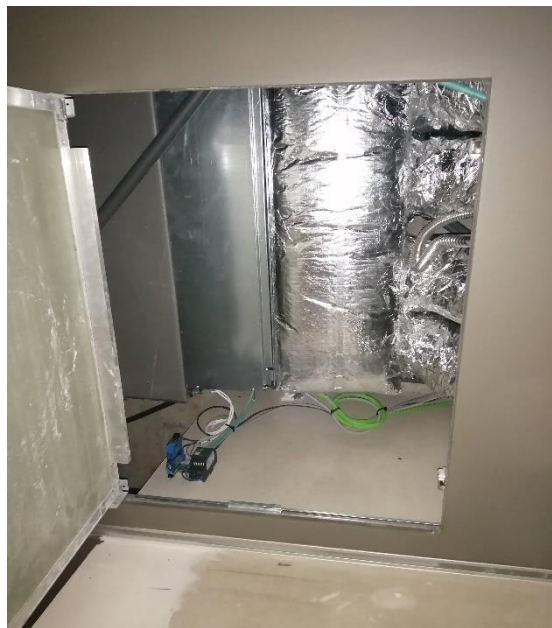
Figura 42 – Exemplo de abertura com alçapão.
