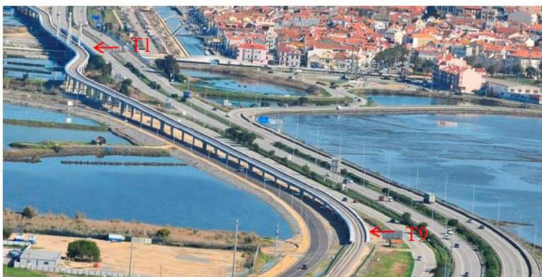
Figura 5.3: Viaduto Poente (Delgado, 2013)
