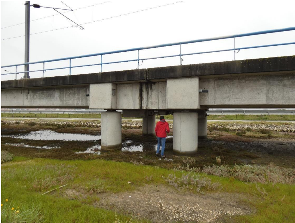
Figura 5.5: Pilares na zona da junta
