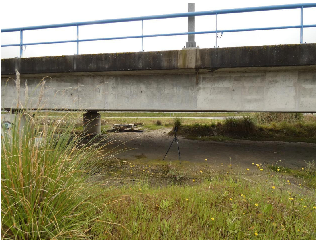
Figura 7.8: Levantamento com laser scanner
