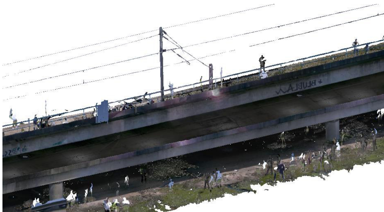
Figura 7.17: Pormenor de um vão – Laser Scan
