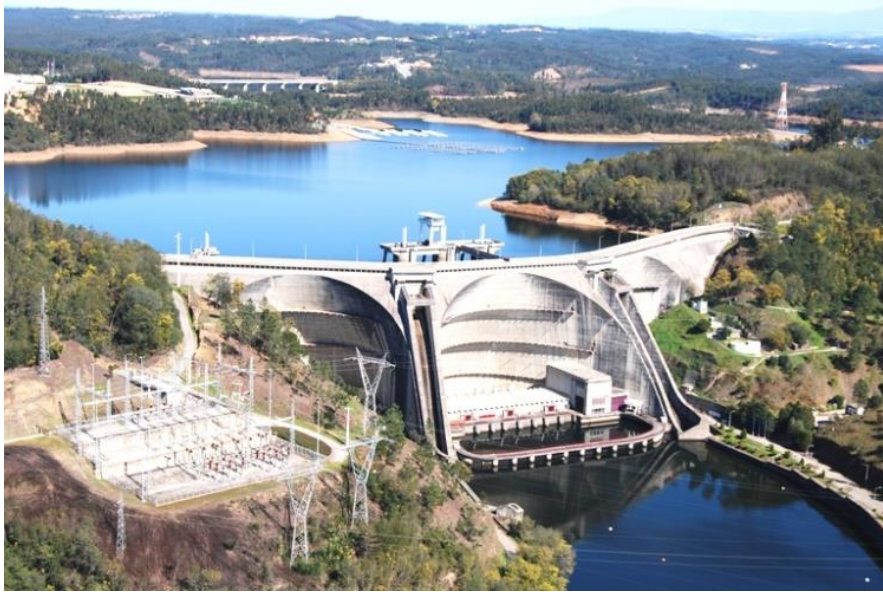
Figura 2.10 - Central hidroeléctrica da Aguieira.
