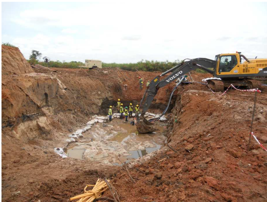
Figura 7.3 – Zona de maciço de Fundação Pilar P2.
