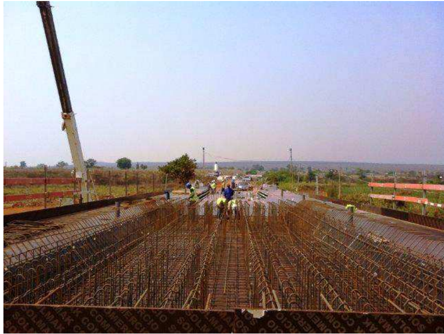
Figura 8.16 –Montagem da Armadura.
