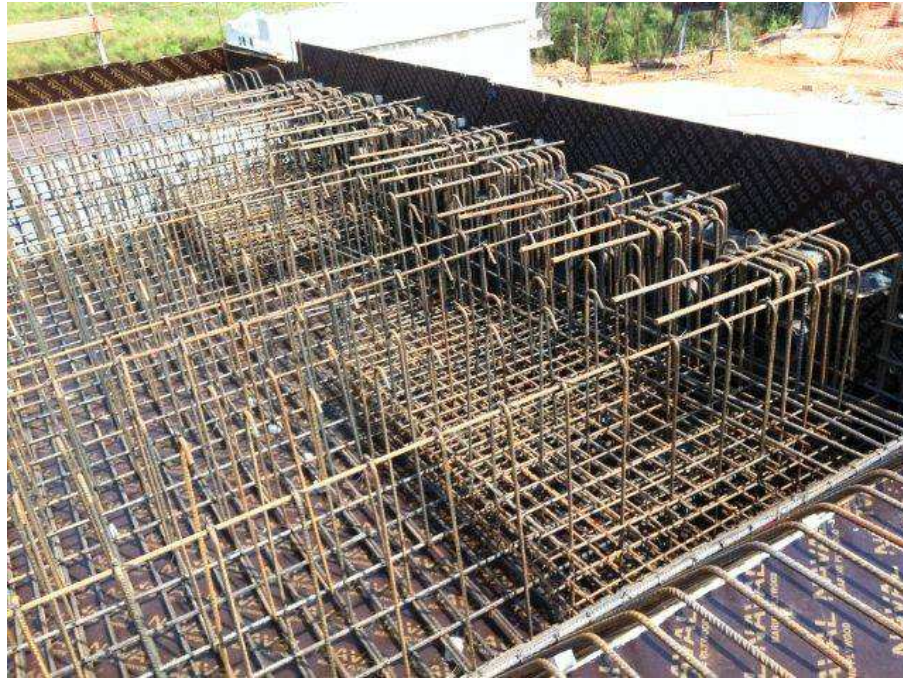
Figura 8.18 – Reforço de armadura nas caixas de ancoragem do pré-esforço.
