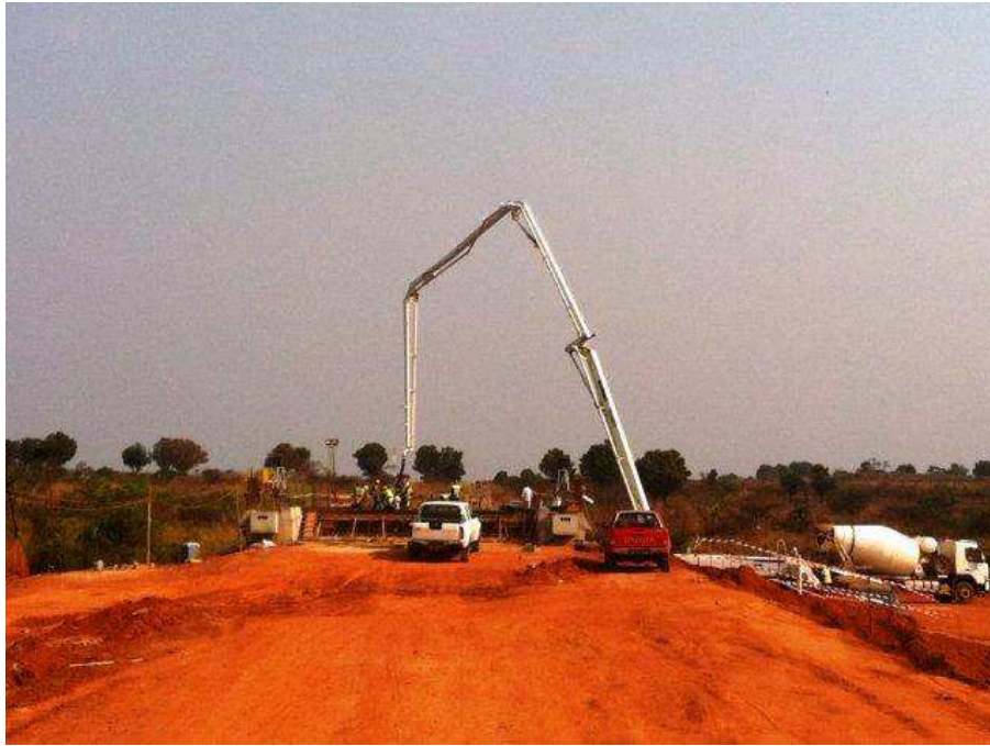
Figura 8.19 – Betonagem do tabuleiro, Auto Bomba e Auto Betoneira no lado direito.
