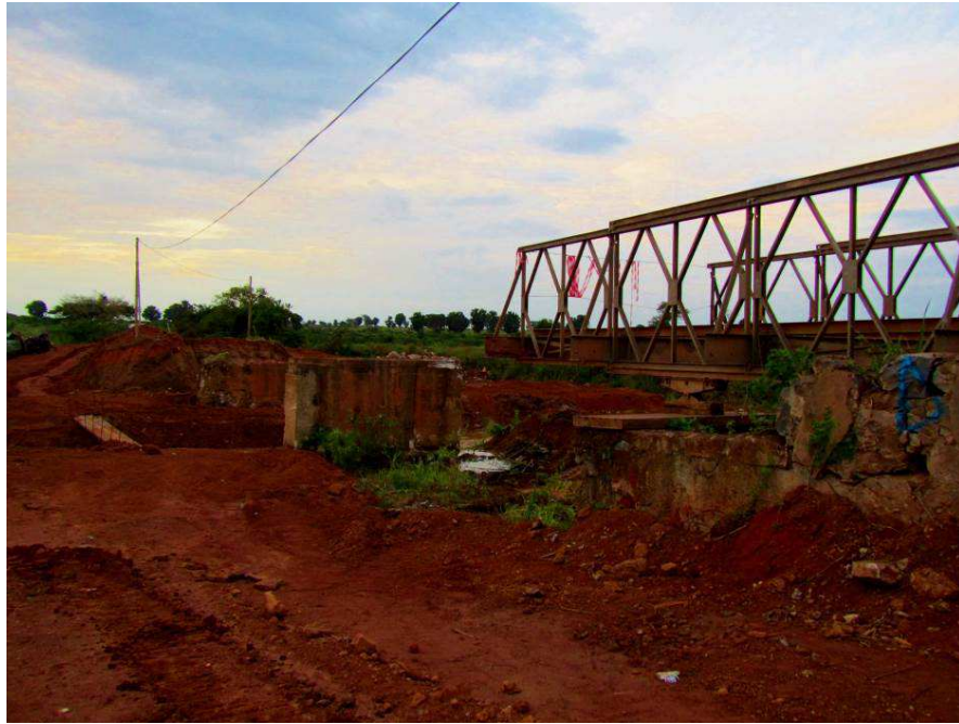
Figura 6.2 – Ponte Metálica Provisória durante processo de arrastamento.
