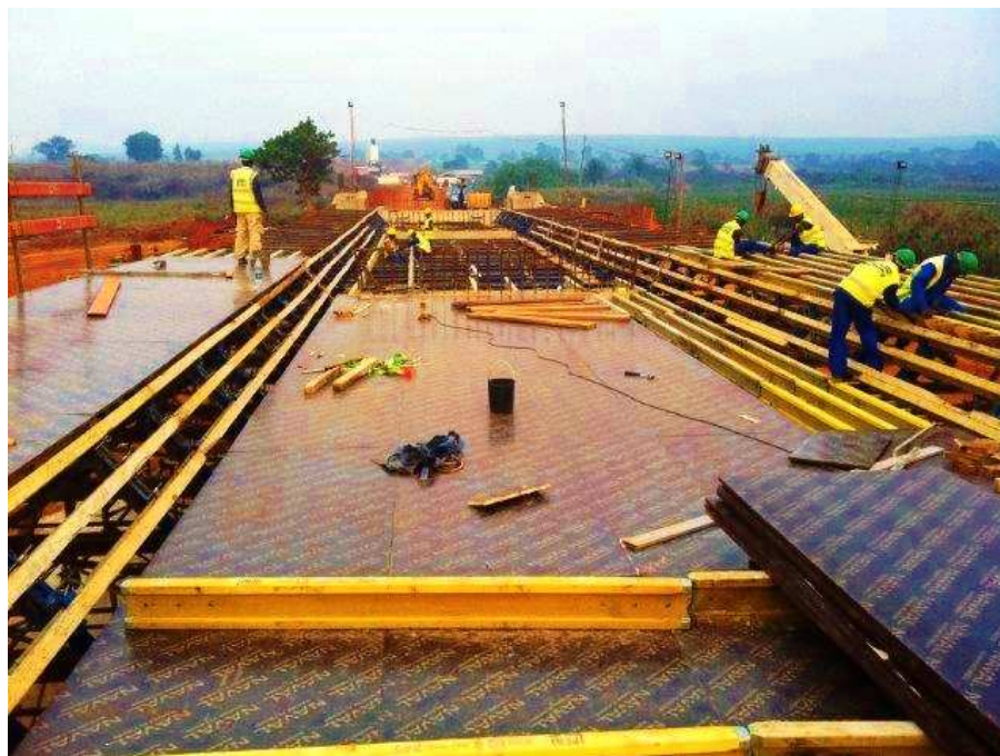
Figura 8.13 – Montagem de cofragem.
