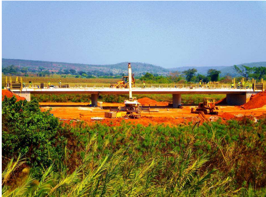
Figura 8.23 – Aspecto final depois de retirar a cofragem e escoramento.
