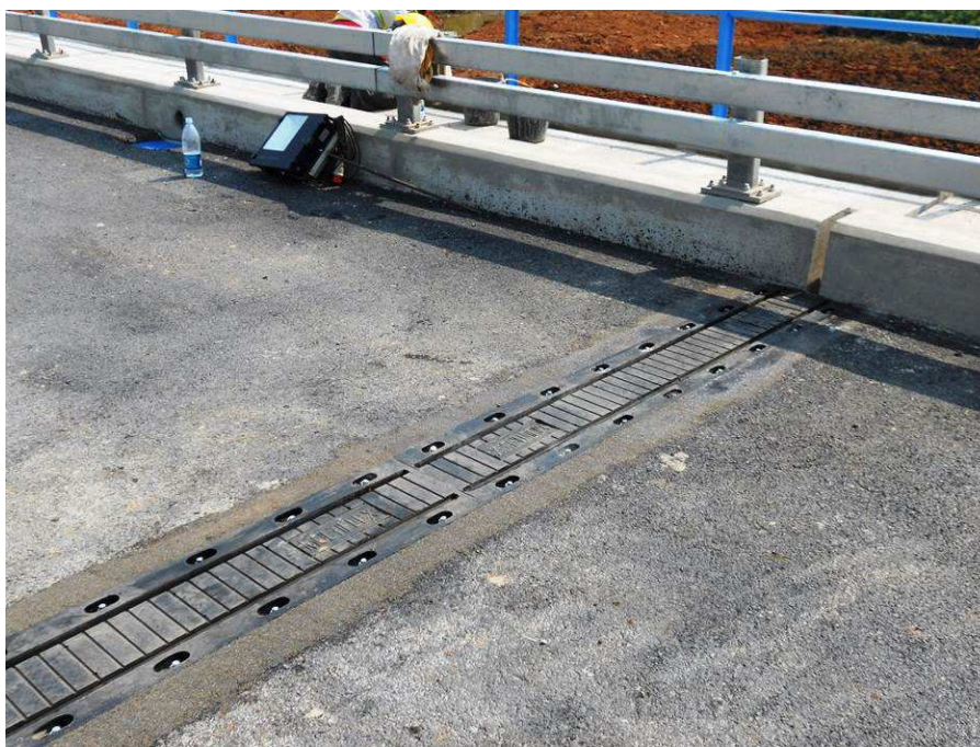
Figura 10.8 – Vista final da junta de dilatação.
