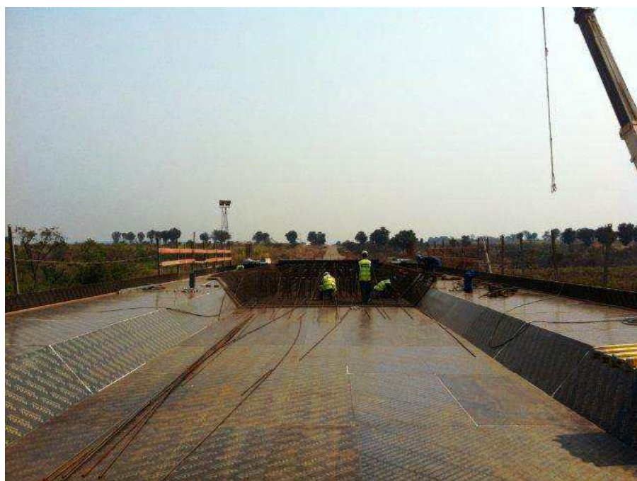
Figura 8.14 – Aspecto final após conclusão de montagem da cofragem.
