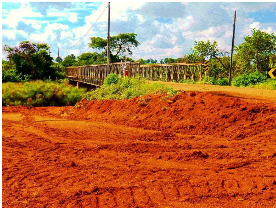
Figura 6.1 – Ponte Metálica Provisória.
