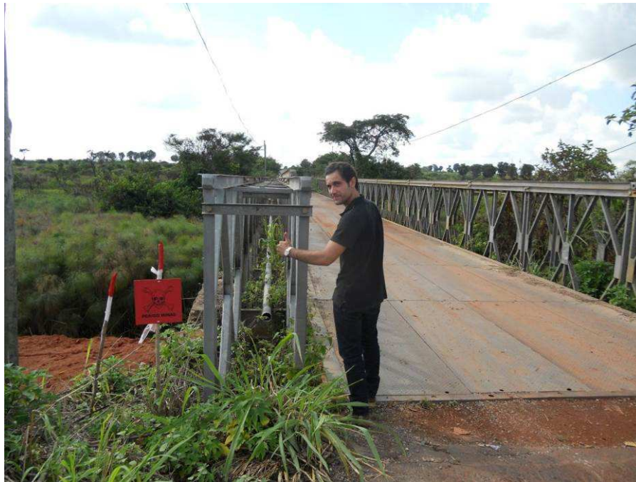
Figura 1.4 – Estrutura Metálica Existente
