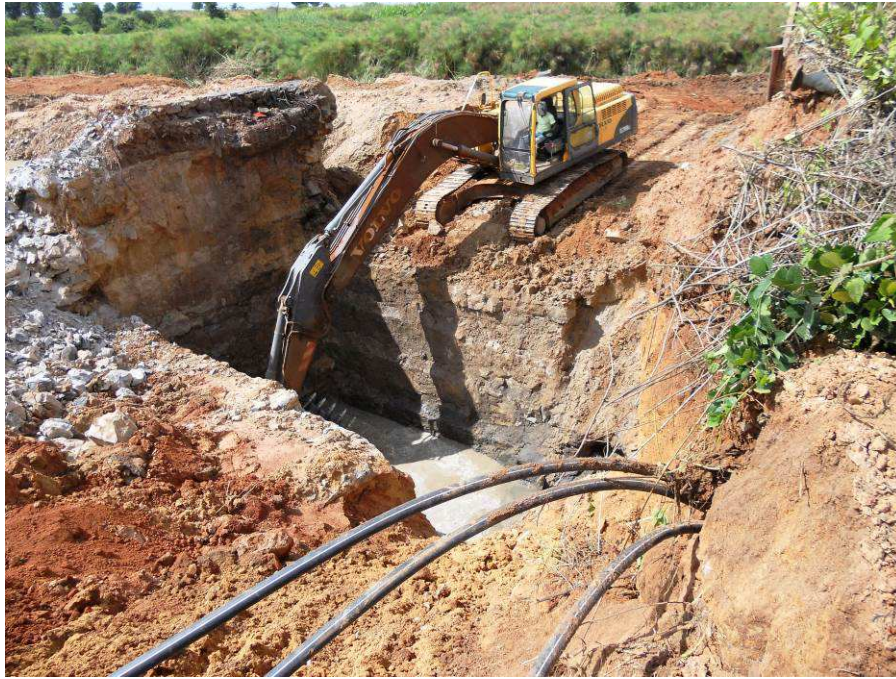
Figura 7.2 – Zona de maciço de fundação do Encontro E2.
