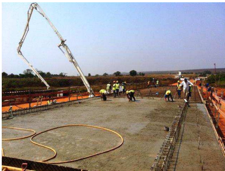
Figura 8.21 – Betonagem do tabuleiro.
