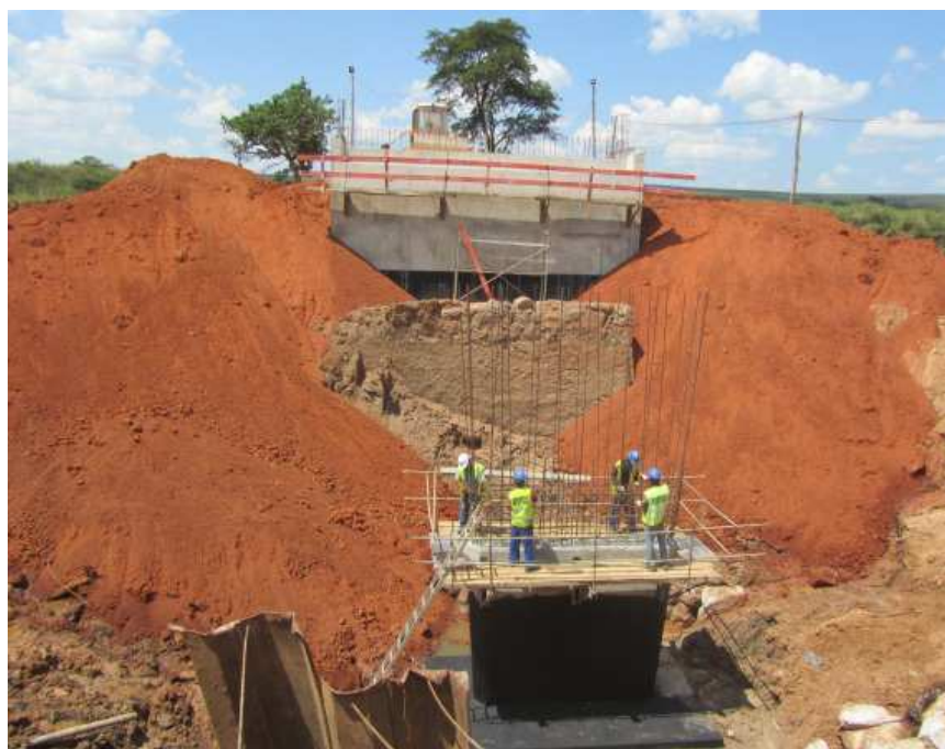
Figura 7.9 –Execução Pilar P2.
