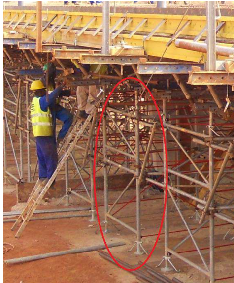
Figura 8.7 – Vista em obra das sistema de cimbra D2.
