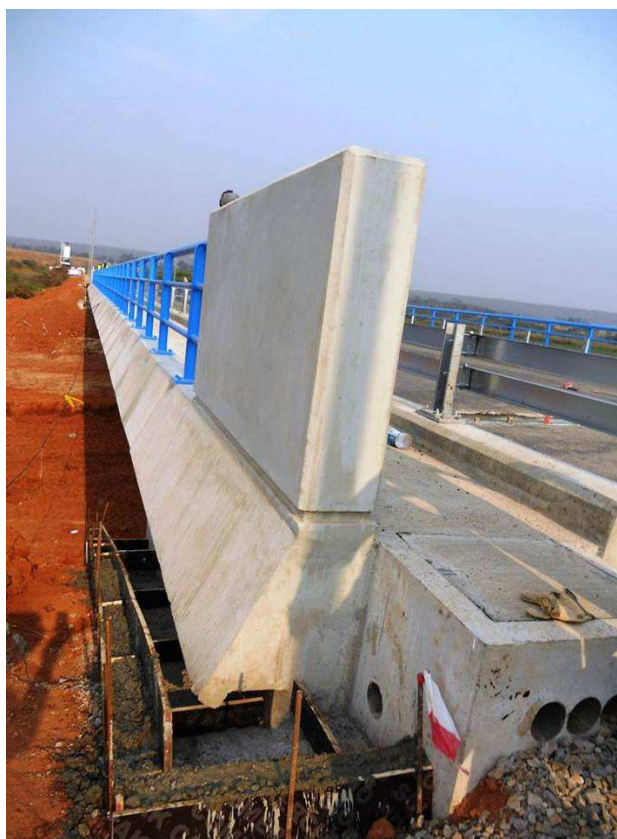
Figura 9.5 – Vista de descida de talude, acrotério, caixa de recção, negativos de PVC e guardas metálicas de segurança.
