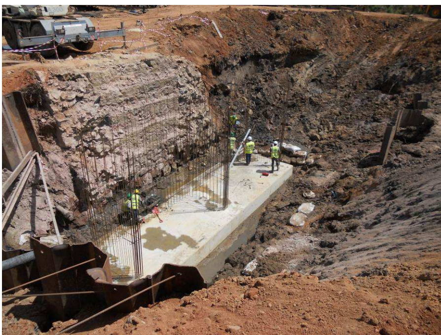
Figura 7.5 – Sapata do Encontro E2 com armadura de arranque.
