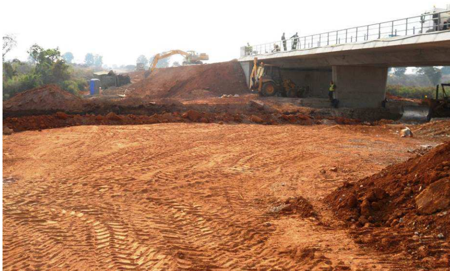
Figura 9.7 – Trabalhos de correcção da trajectória do rio e reperfilamento de taludes.
