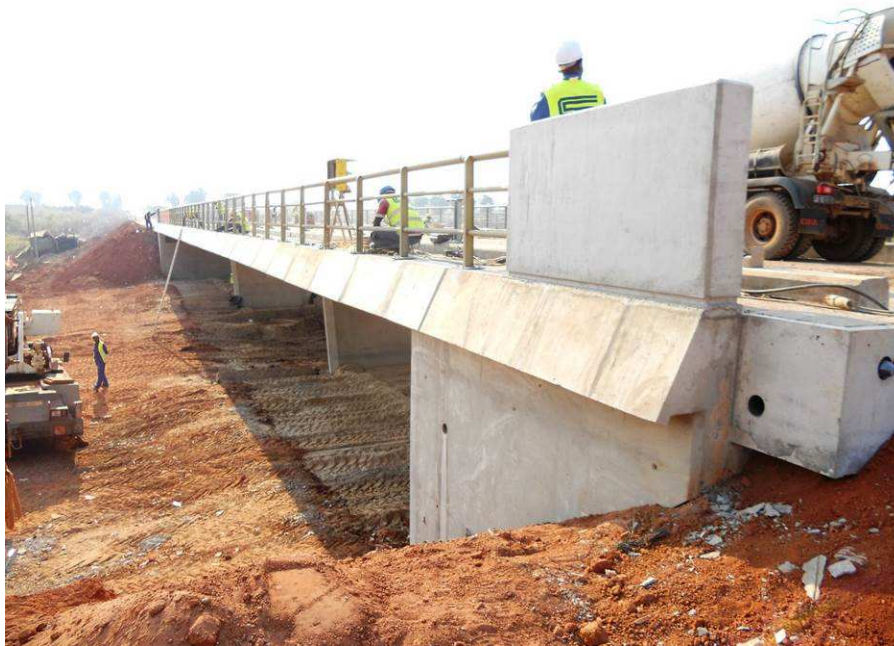
Figura 9.3 – Vista em obra da viga bordadura e Guarda Corpos.
