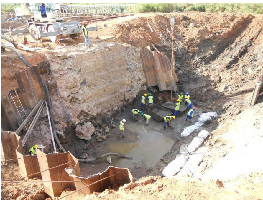
Figura 7.1 – Zona de maciço de fundação do Encontro E2.
