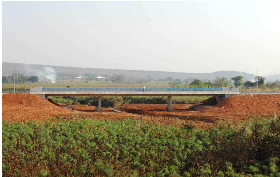
Figura 11.1 – Aspecto final da Ponte Sobre o Rio Lombe.
