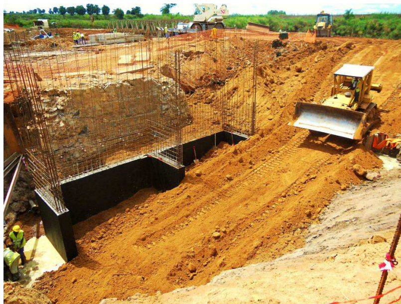
Figura 7.7 – Aterro dos Elementos Estruturais Encontro E2. Paredes dos encontros já revestidas com com uma camada de impermeabilização com emulsão betuminosa.
