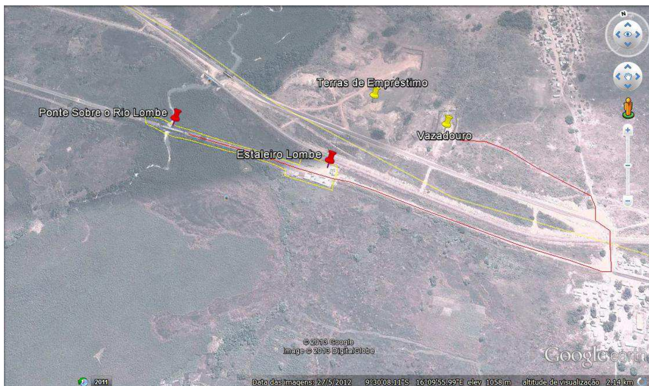
Figura 6.4 – Distancia do Estaleiro Frente Obra em relação ao vazadouro e terras de empréstimo (1,5 km).
