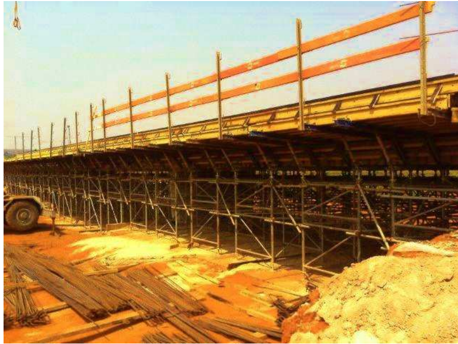
Figura 8.2 – Vista em Obra da cofragem racional Top50.
