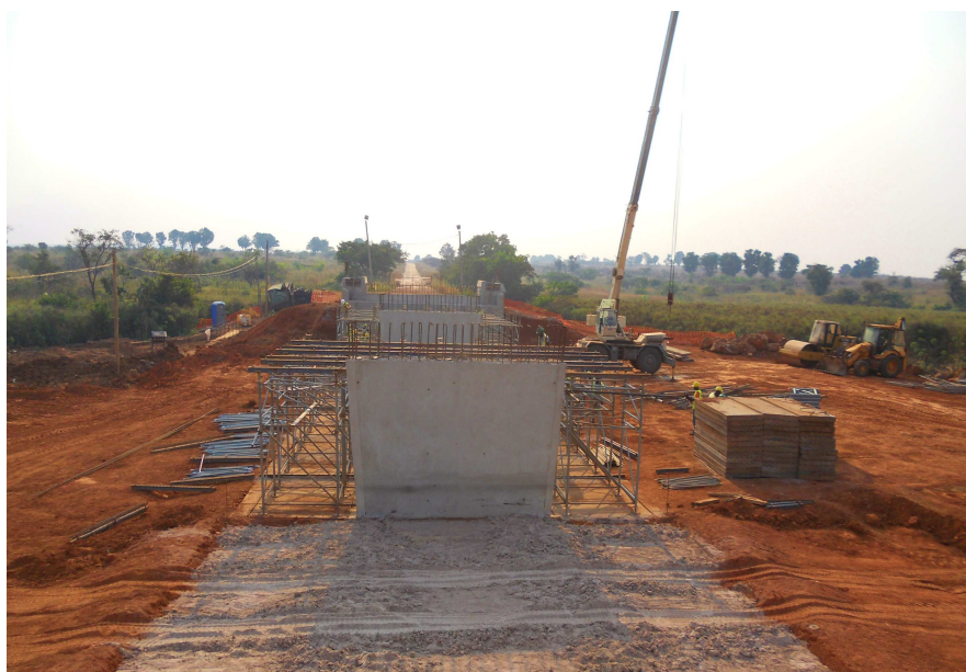
Figura 8.10 – Início de montagem do cimbra.
