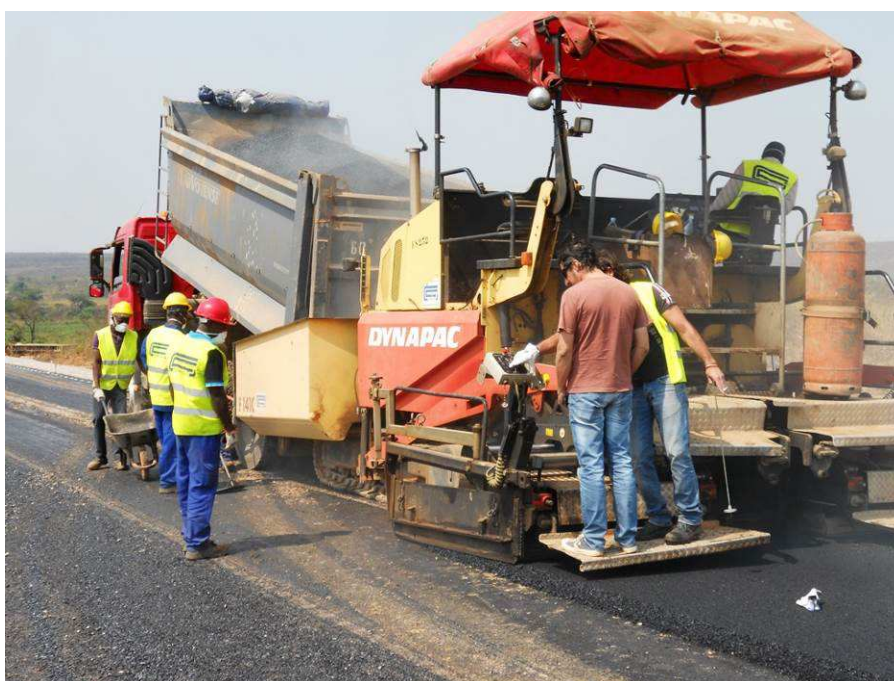
Figura 10.3 – Vista da espalhadora e camião basculante durante a pavimentação.
