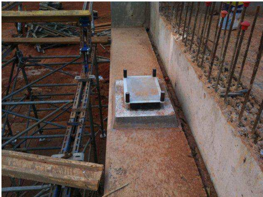
Figura 8.12 – Aparelho de apoio.
