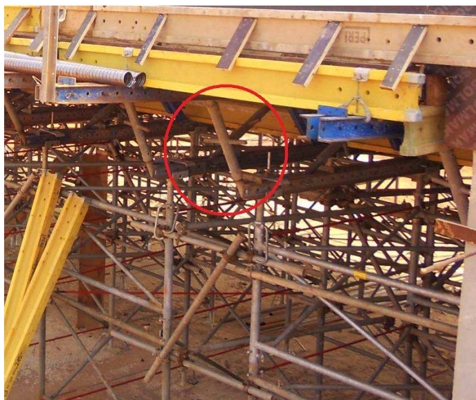
Figura 8.6 – Vista em obra das escoras de eixo roscado T7 100/150.
