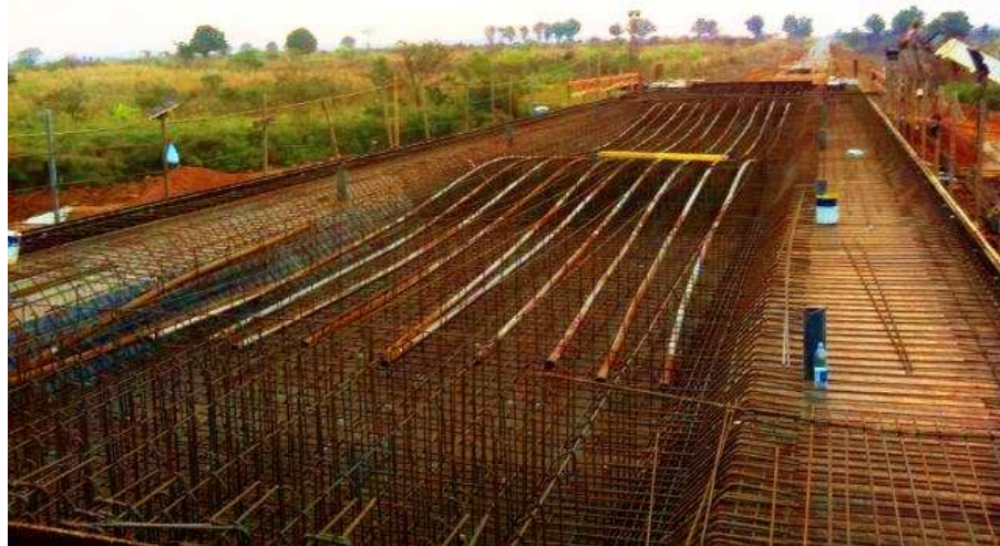
Figura 8.17 –Armadura do tabuleiro e bainhas de pré-esforço.
