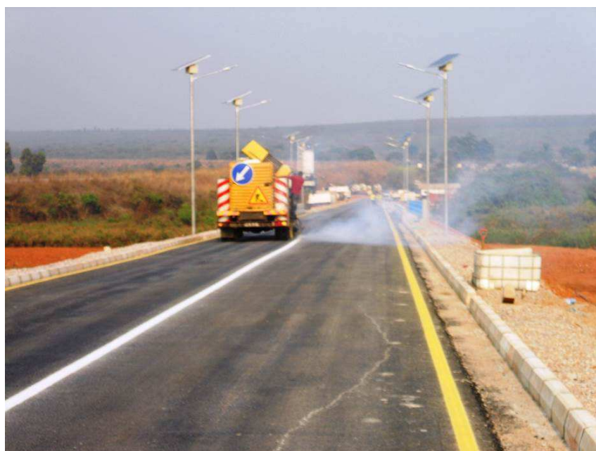
Figura 10.9 – Execução das pinturas horizontais.
