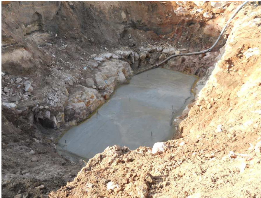
Figura 7.4 – Betão de limpeza na zona da sapata do Encontro E1
