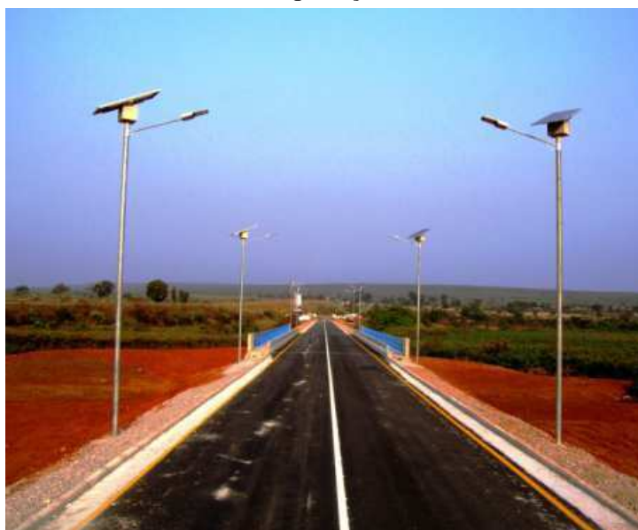
Figura 9.6 – Vista geral do tabuleiro e postes de energia solar
