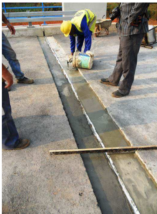
Figura 10.7 – Execução de junta de dilatação.
