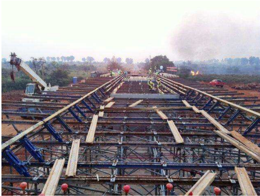
Figura 8.11 – Sistema de cimbra concluído, início de montagem de cofragem.
