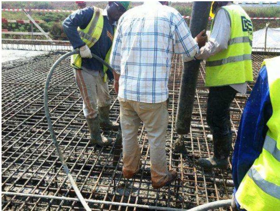
Figura 8.20 – Betonagem do tabuleiro e vibração do betão.
