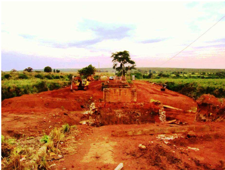
Figura 6.3 – Local da Nova Ponte, elementos estruturais antigos e parcialmente demolidos.
