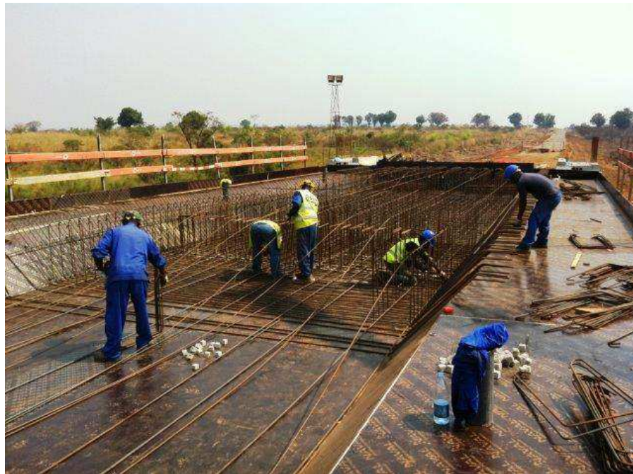
Figura 8.15 –Montagem da Armadura.
