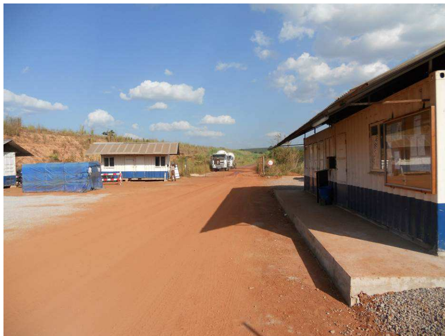
Figura 3.3 – Instalações Administrativas (lado direito), Casa dos Guardas (ao fundo lado esquerdo).
