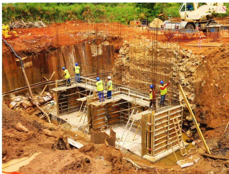
Figura 7.6 – Execução das paredes do Encontro E2 .
