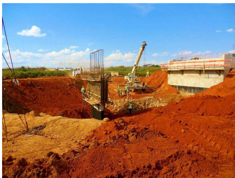
Figura 7.10 –Execução Pilar P2.
