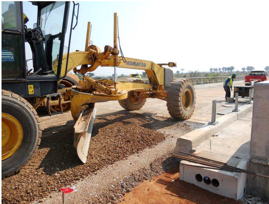
Figura 10.6 – Colocação de base para nivelamento das lajes de transição.
