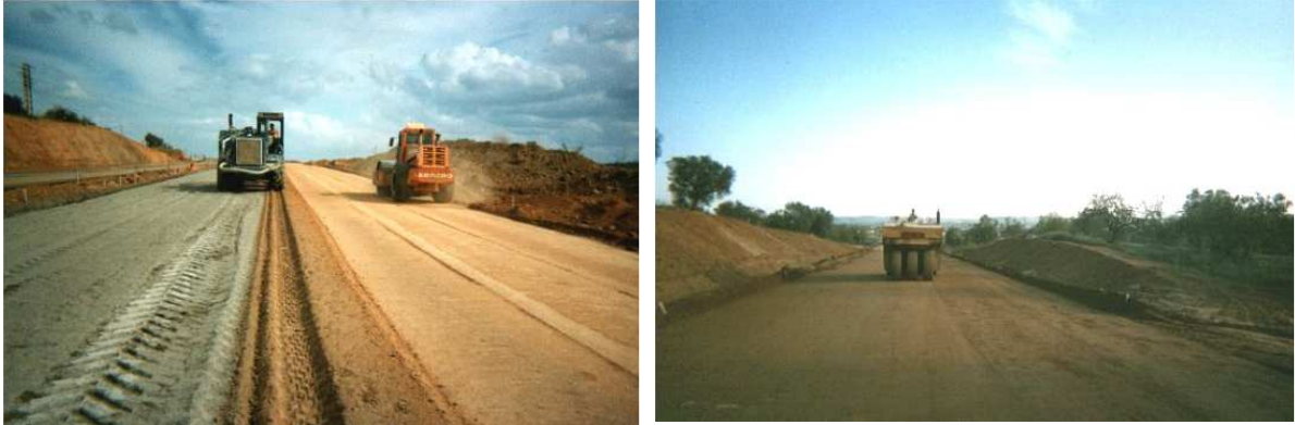
Figura 28 - Compactação em fase inicial e de acabamento (Caspurro e Dias, 2008).
