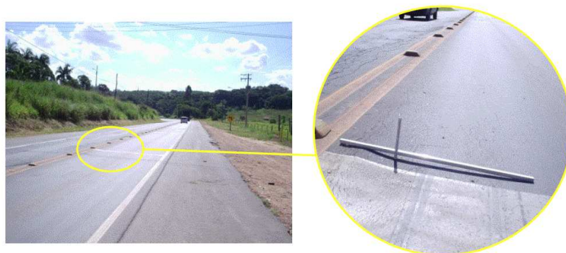
Figura 47 - Flecha na faixa de rodagem (DER/SP, 2006).
