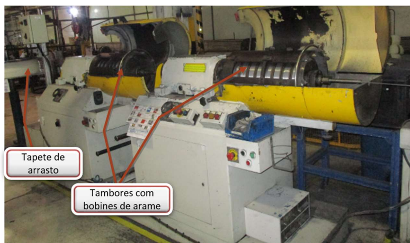
Figura 106 - Abastecimento de arames e tubo interior.
