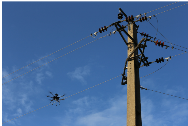
Figura 1.4: Byrd I em processo de inspeção autónoma de um apoio de Média Tensão.
