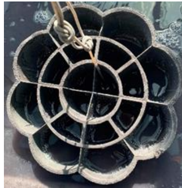
Figura 3.3 - Peças de enchimento utilizadas nos leitos percoladores
