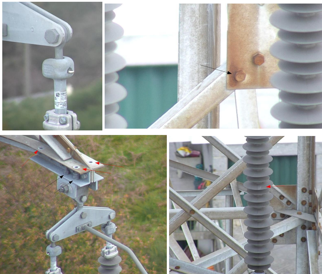
Figura 67 – Pormenores detetados na demonstração de inspeção de pormenor (fonte: REN)
