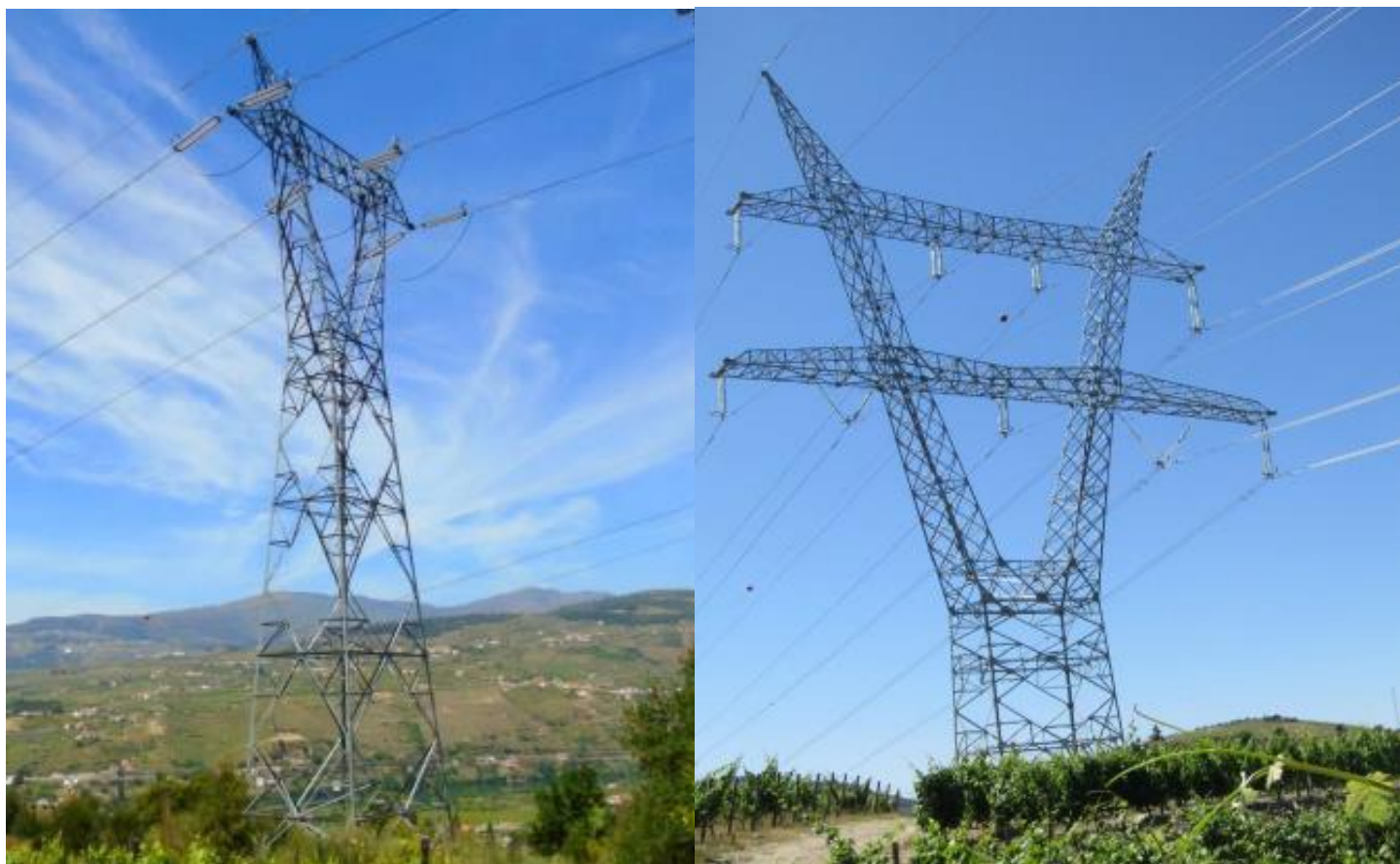
Figura 3 – Apoio simples de amarração; Apoio triplo de suspensão [6]
