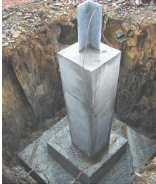
Figura 4 – Fundação de um Apoio [5]
