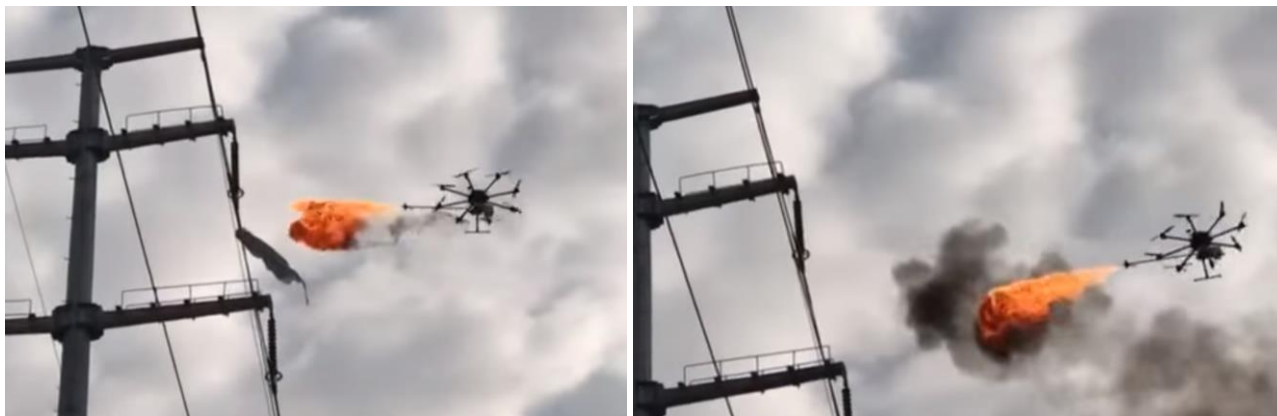
Figura 82 – Limpeza de plásticos através de um lança-chamas com recurso a UAV [97]
