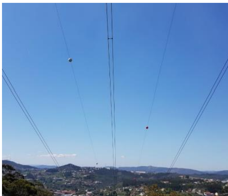
Figura 14 – Balizagem diurna espaçada e alternada nos cabos de guarda [6]
