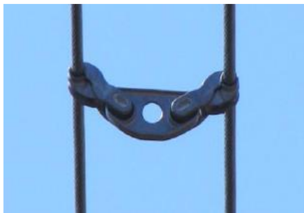
Figura 12 – Separador de feixe com capacidades amortecedoras [6]
