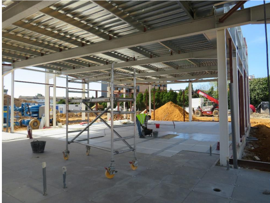
Figura 4.3 - Estrutura porticada
