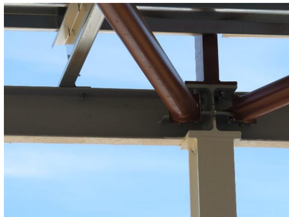
Figura 4.8 – Ligação contraventamentos
