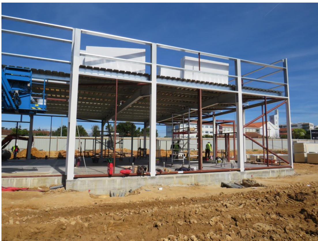
Registo fotográfico de obra localizada em Santa Maria da Feira
