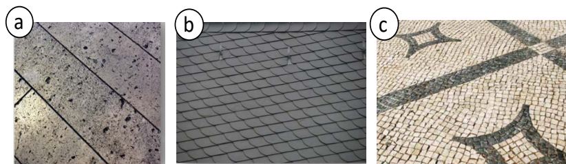
Figura 8 - a) Azulejos de calcário; b) Telhas de ardósia; c) Cubos na calçada portuguesa. (Almeida & Amado, 2018 b; Henriques et al., 2009)
