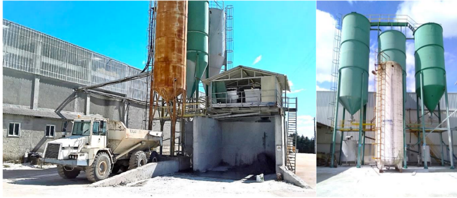
Figura 11 - Estação de tratamento de lamas na empresa. (Silva, 2018)
