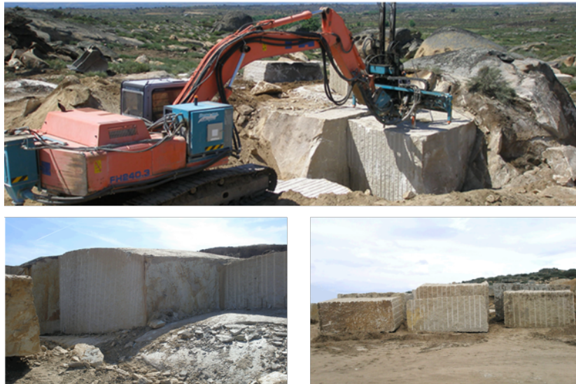
Figura 4 - Desmonte de granito com utilização de explosivo. ( http://www.granitosmariofigueiredo.com/extracao.php )
