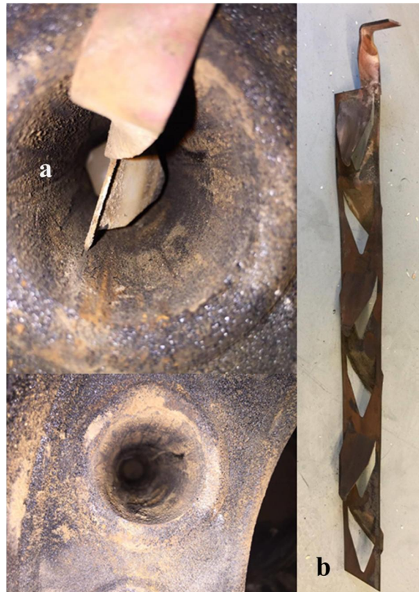
Figura 12 Turbuladores existentes na caldeira: a) Zona de encaixe; b) Turbulador
