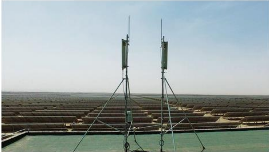
Figura 34: Antenas de transmissão wireless [20].
