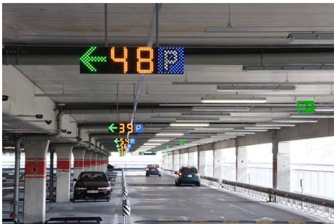
Figura 3 – Exemplo da interface com o utilizador de um sistema de controlo e contagem. (fonte: (Park, Global, 2016))
