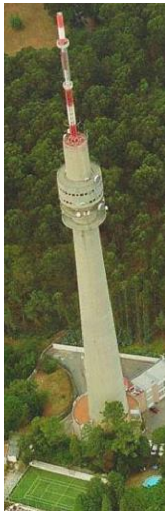
Figura 2.1 – Torre do Monte da Virgem, em Vila Nova de Gaia
