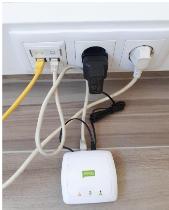
Figura 49 – Instalação do Hub
