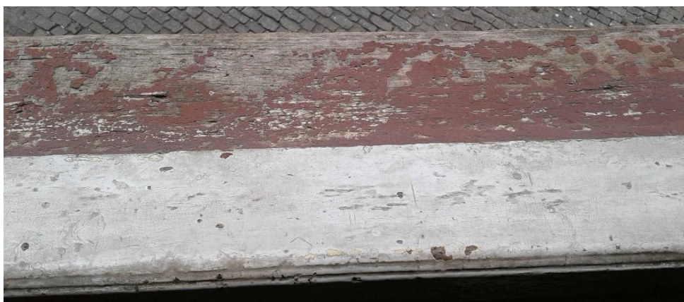
Figura 5.40 – Peitoril de um dos envidraçados.
