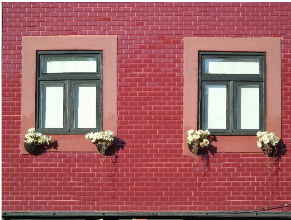
Figura 2.4 - Fachada revestida a cerâmica.
