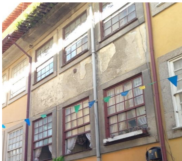
Figura 5.38 – Envidraçados presentes no edifício em análise.
