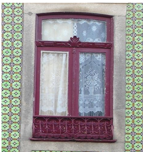
Figura 4.11 - Caixilhos de madeira em relativamente bom estado (embora com deficiências de pintura).
