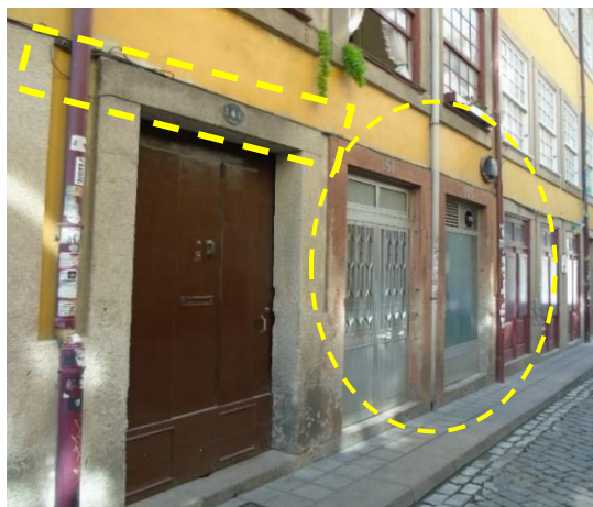
Figura 5.43 – Elementos de cantaria na zona de entrada e comércio.
