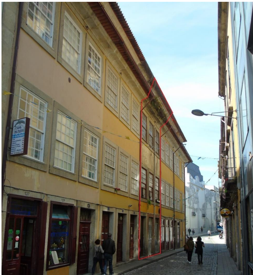
Figura 5.2 - Edifício em estudo.
