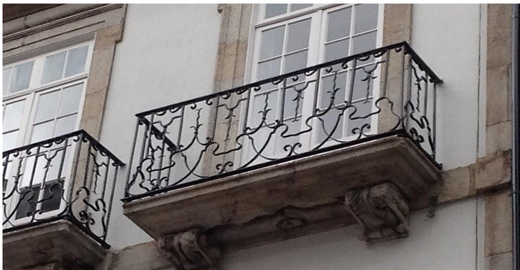
Figura 2.20 – Guarda metálica de varanda.
