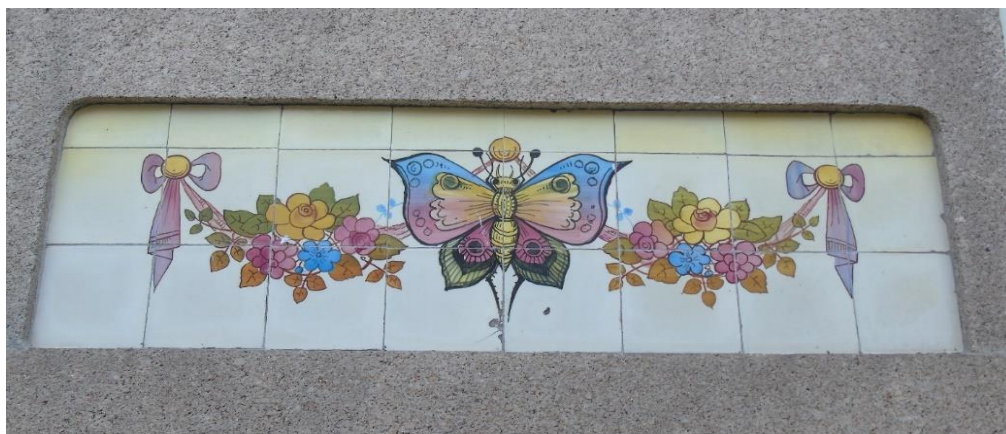
Figura 4.3 – Revestimento cerâmico devidamente reabilitado e preservado.
