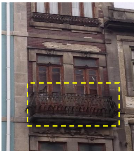
Figura 3.22 - Guarda metálica de varanda.
