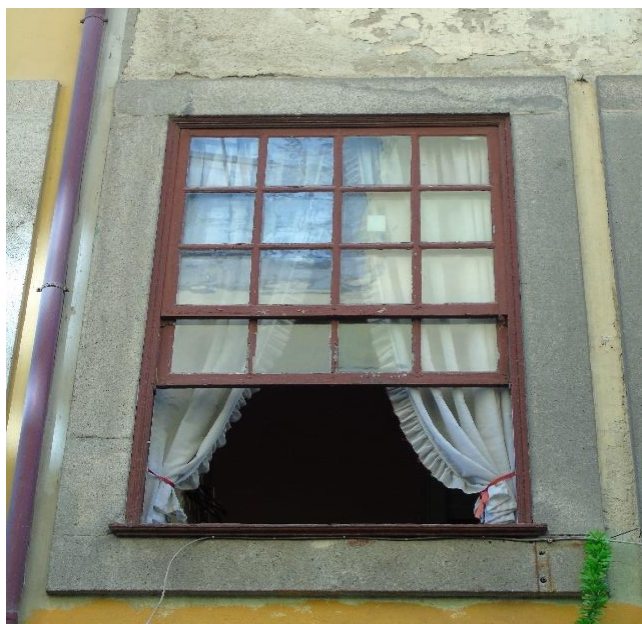
Figura 5.36 – Esquadrias em cantaria nos envidraçados.
