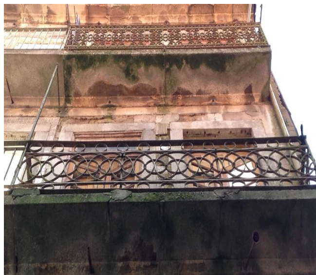
Figura 4.16 – Guarda em ferro forjado na varanda do 1º piso em ferro fundido no 2º piso com outra ornamentação.
