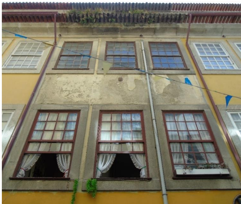
Figura 5.32 – Fachada do edifício em estudo.
