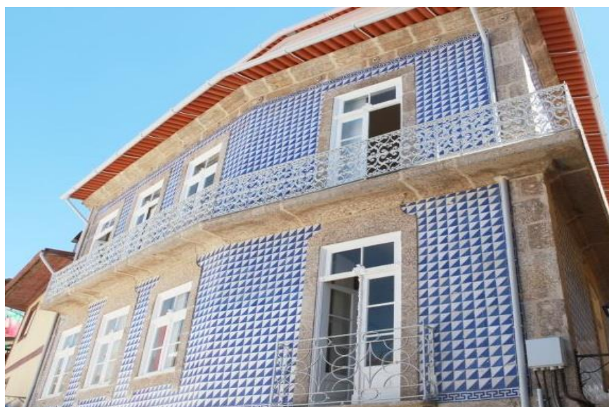
Figura 4.12 - Caixilharias de madeira reabilitadas.
