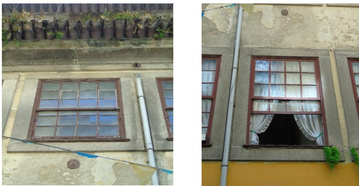
Figura 5.42 – Peças de cantaria presentes na fachada.
