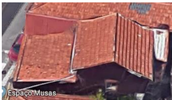
Figura 38 – Cobertura do edifício
