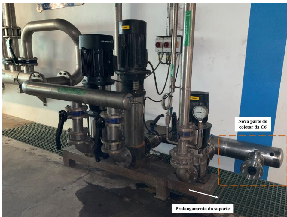
Figura A. 1 - Fotografia do coletor de distribuição de água da cisterna 6 depois da intervenção e indicação do suporte que é necessário prolongar.
