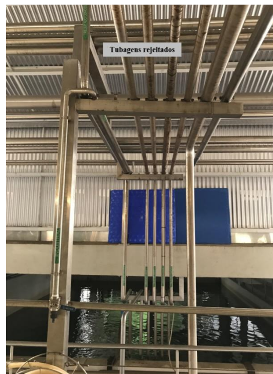
Figura D. 6 - Fotografia do direcionamento dos rejeitados para a cisterna 2.
