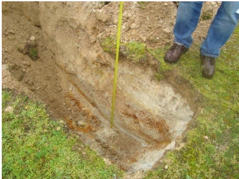
Fotografia 20 - Profundidade a que se obteve o firme (1.20 metros)
