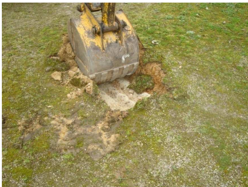
Fotografia 9 - Remoção da terra vegetal
