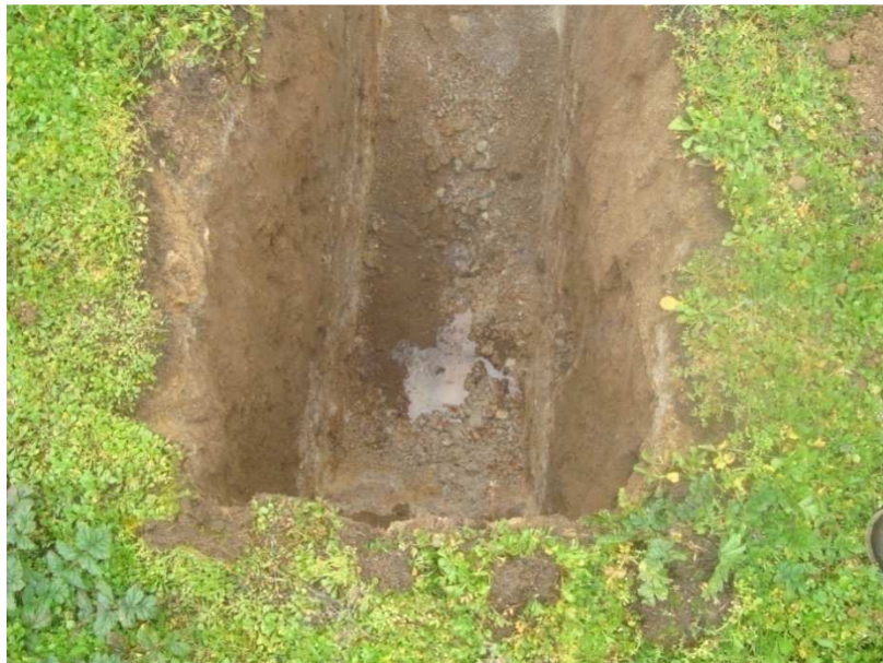
Fotografia 12 - Profundidade a que se obteve o firme (2.00 metros)
