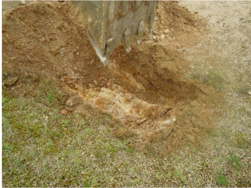
Fotografia 15 - Escavação à profundidade de 0.30 metros
