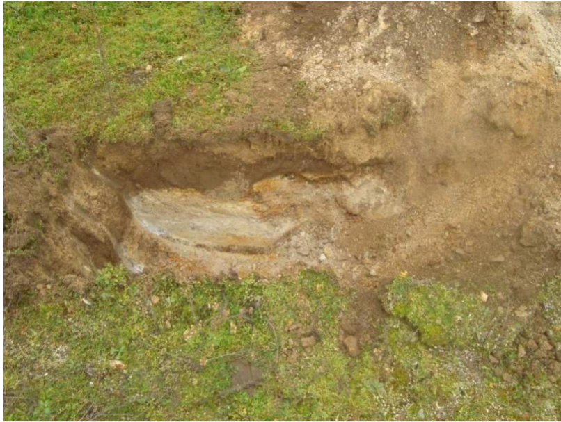
Fotografia 13 - Escavação à profundidade de 0.30 metros
