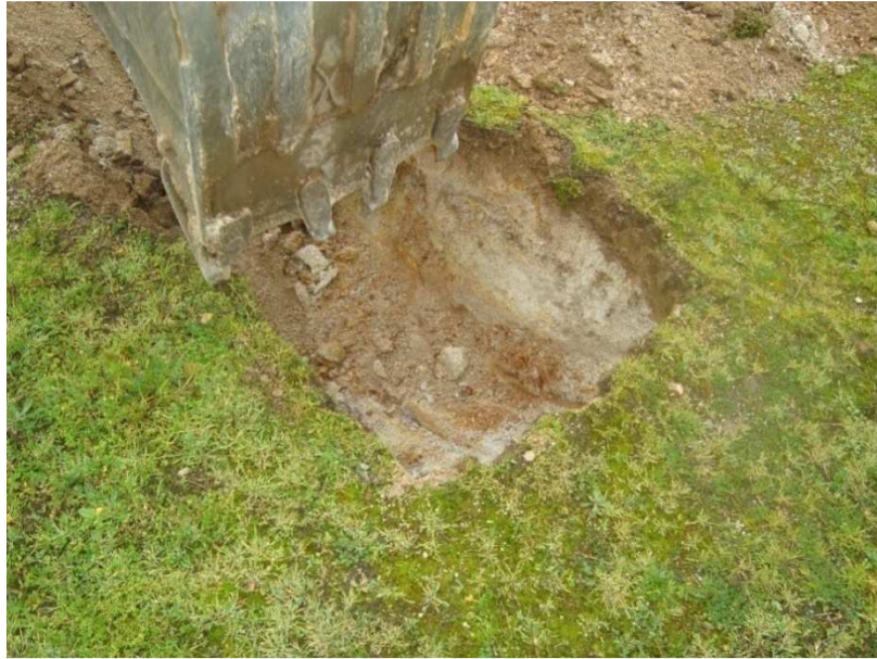
Fotografia 19 - Escavação à profundidade de 0.50 metros
