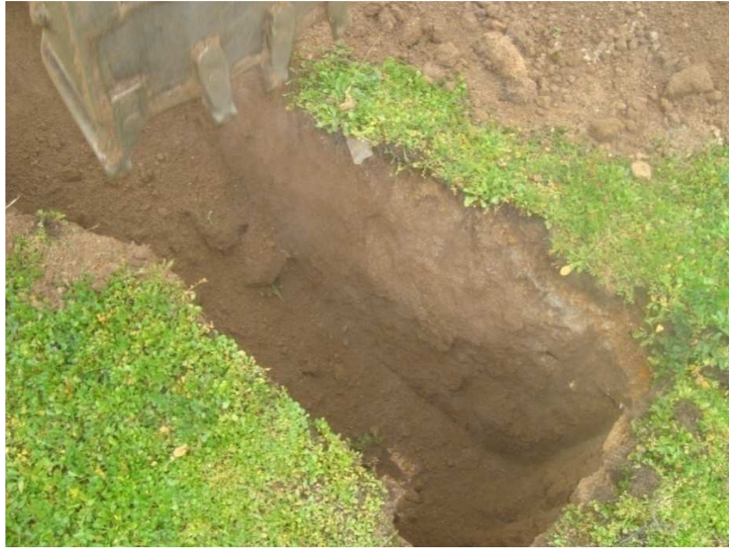
Fotografia 11 - Escavação à profundidade de 0.80 metros
