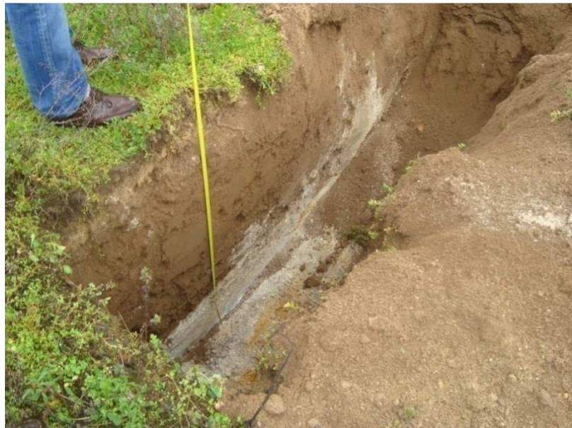
Fotografia 18 - Profundidade a que se obteve o firme (1.50 metros)
