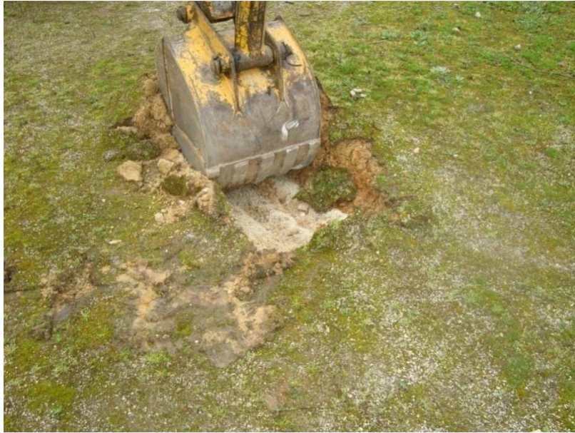
Fotografia 21 - Remoção da camada de terra vegetal
