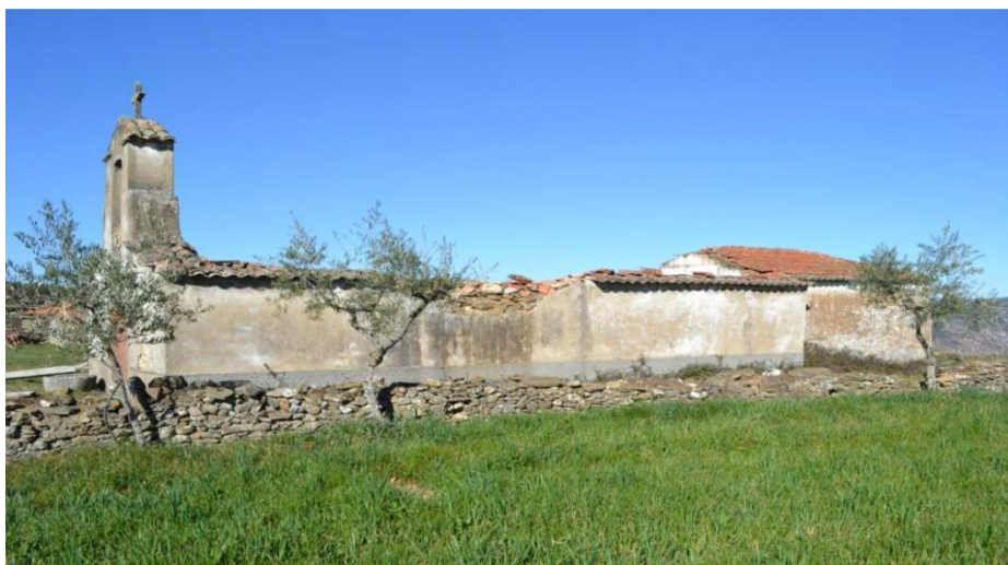
Fotografia 30 - Capela de Santo Amaro – Exterior
