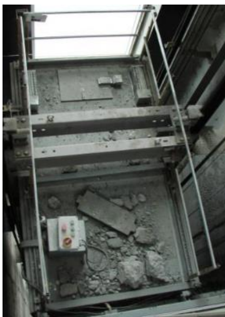
Figura 27 - Queda de pesos em cima da cabina (Adaptado - [22])
