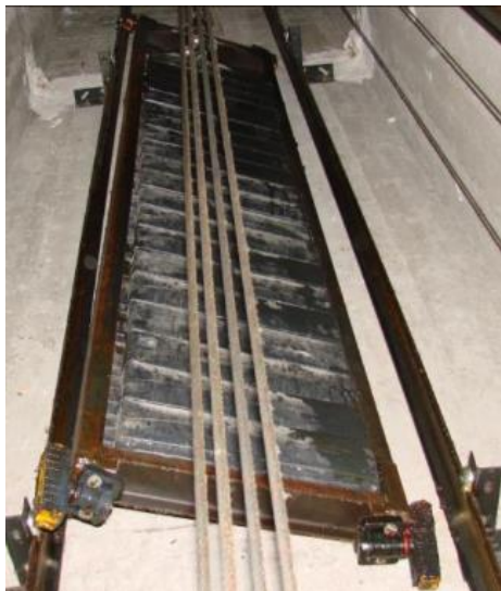
Figura 19 – Dano nas roçadeiras e descarrilamento do contrapeso (Adaptado - [22])
