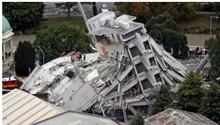
Figura 13 - Terramoto de Christchurch - edifício Pyne Gould Guinness (Adaptado - [11])
