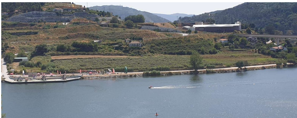
Figura 1 - Frente de Rio Douro - 350 m (vista da margem direita)
